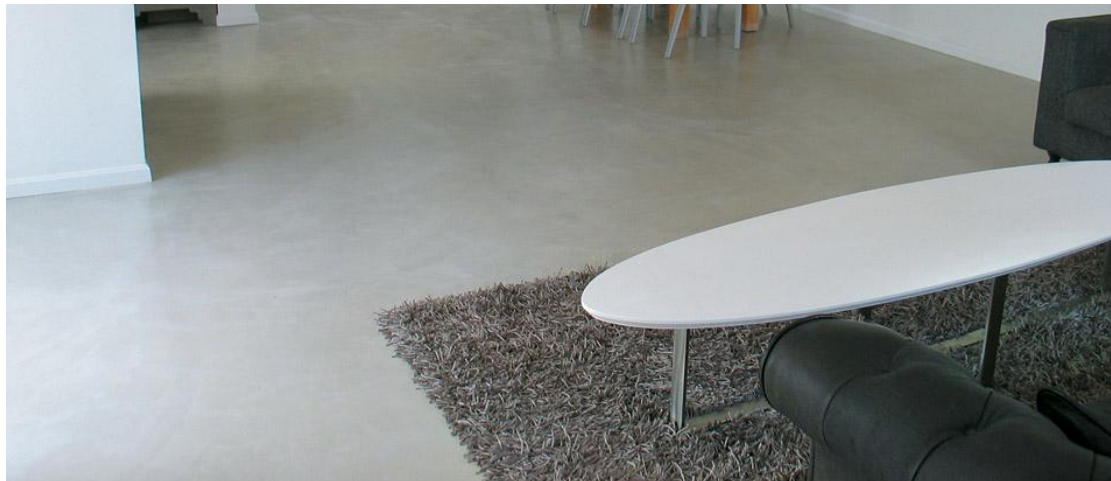
Kuva 19. Pinnoitettu betonilattia (Designbetoni, 2015)
