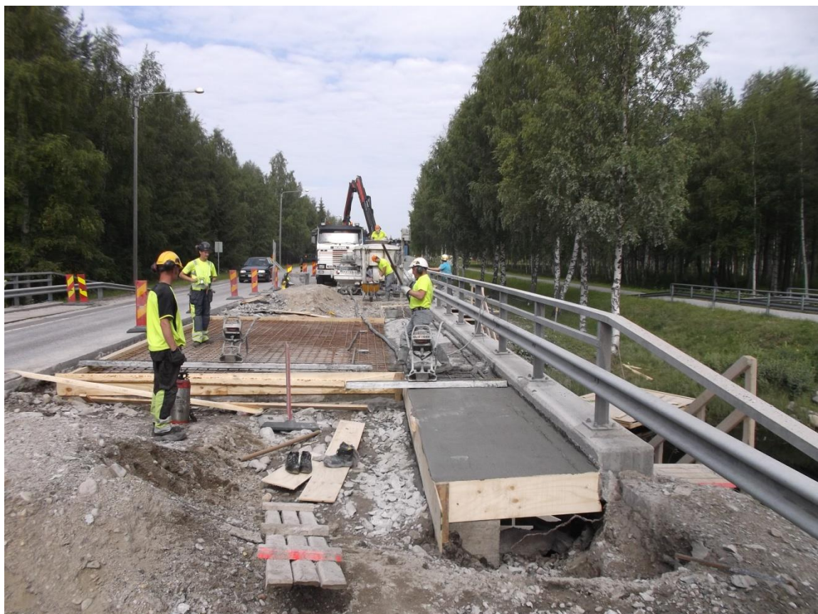
Kuva 14. Kannen muotoiluvalu IT-betonilla. Sokojoen silta, Lieksa. (Kortelainen Tomi)
