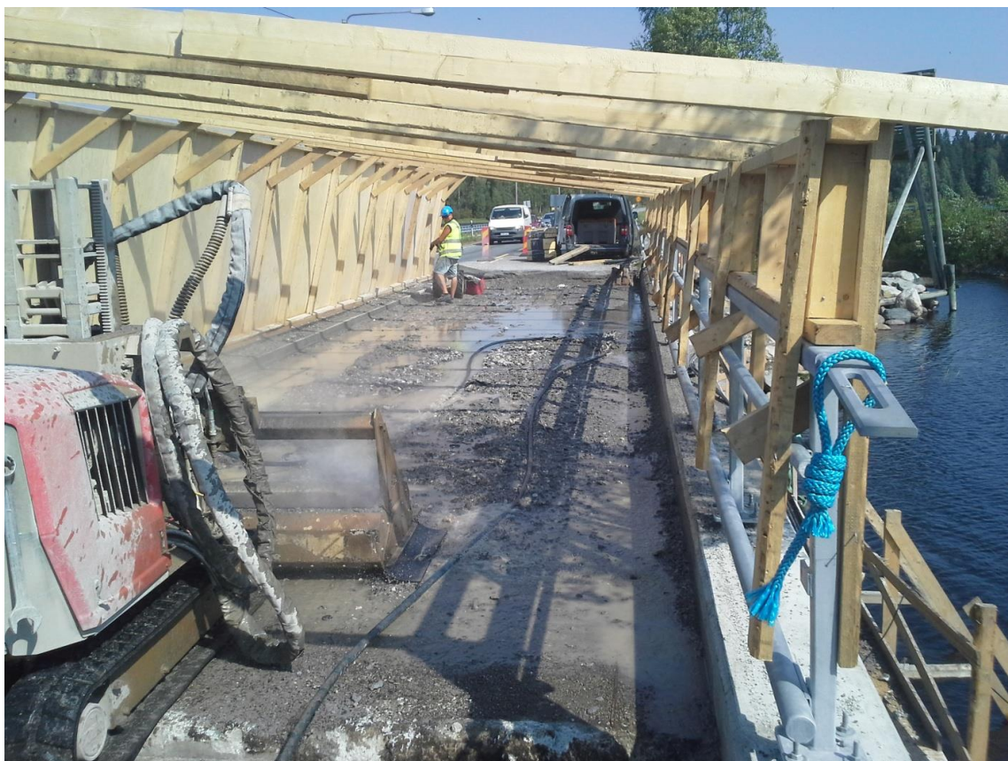
Kuva 10. Vesipiikkausyksikkö sillan kannella. (Romppainen Aleks)
