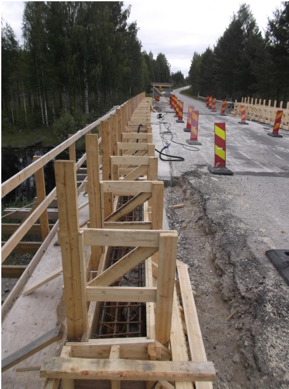
Kuva 11. Reunapalkin muotti, Ulkajoen silta, Lieksa. (Kortelainen Tomi)
