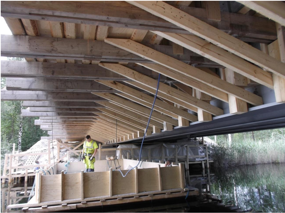
Kuva 8. Valmiit työtelineet alhaalta päin kuvattuna. (Kortelainen Tomi)
