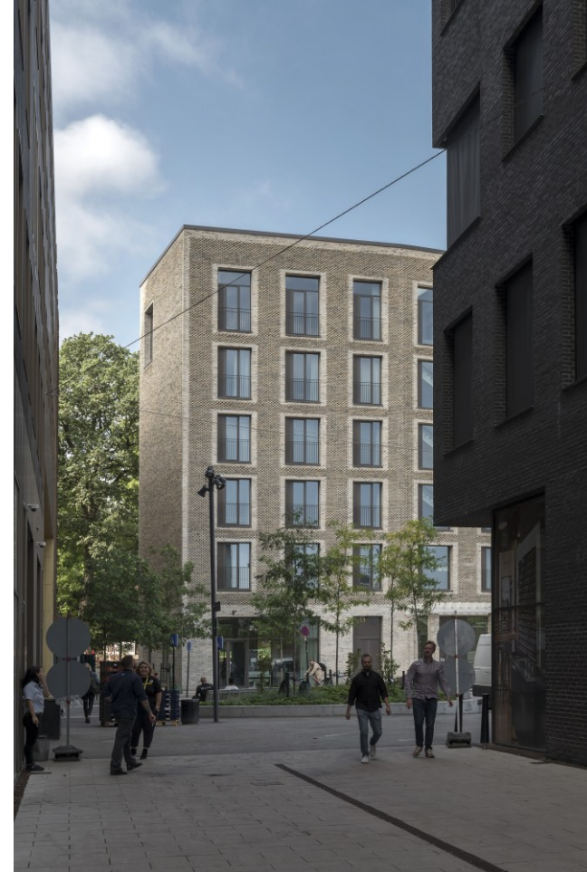
Kuva 27: Maantasokerros ja pääjulkisivu eroavat toisistaan tiililadonnalla. (Kuva: Carlsbergfondets Forskerboliger i Carlsberg Byen)
