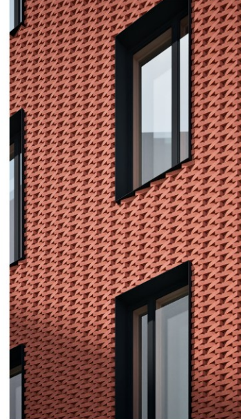
HAVAINNEKUVA JULKISIVUSTA Kobber EW0466, Egemsund Wienerberger Juoksumitys 1/3, tiilet on käännetty 25 astetta ulospäin.
