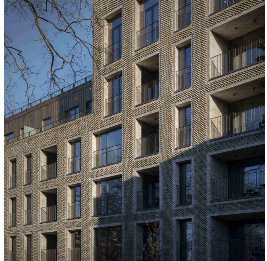
Kuva 26: Julkisivu Parkis architecture suunnittelemaa Researcher Apartments rakennuksesta. Julkisivussa on yhdistetty tiilen erilaista ladontatapa. Se tuo julkisivuun vaihtelevuutta ja reliefipinnan. (Kuva: Carlsbergfondets Forskerboliger i Carlsberg Byen)
