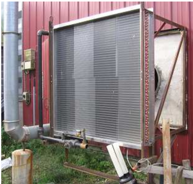
Kuva 5.2 Patteri asennettuna paikoilleen.
