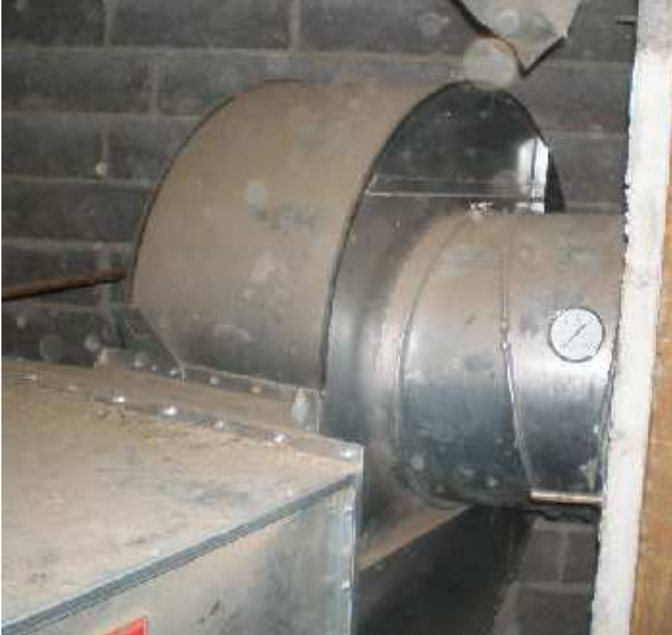
Kuva 3.1 Puhallin, jota ennen patteri asennetaan.
