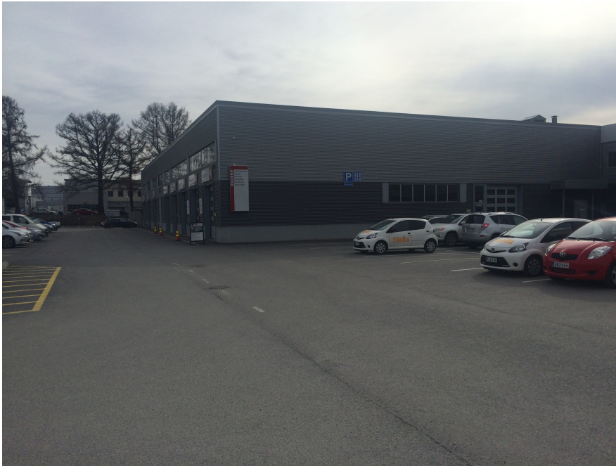
KUVA 2 PIKAHUOLLON NOSTO-OVET NURKAN TAKANA VASEMMALLA
