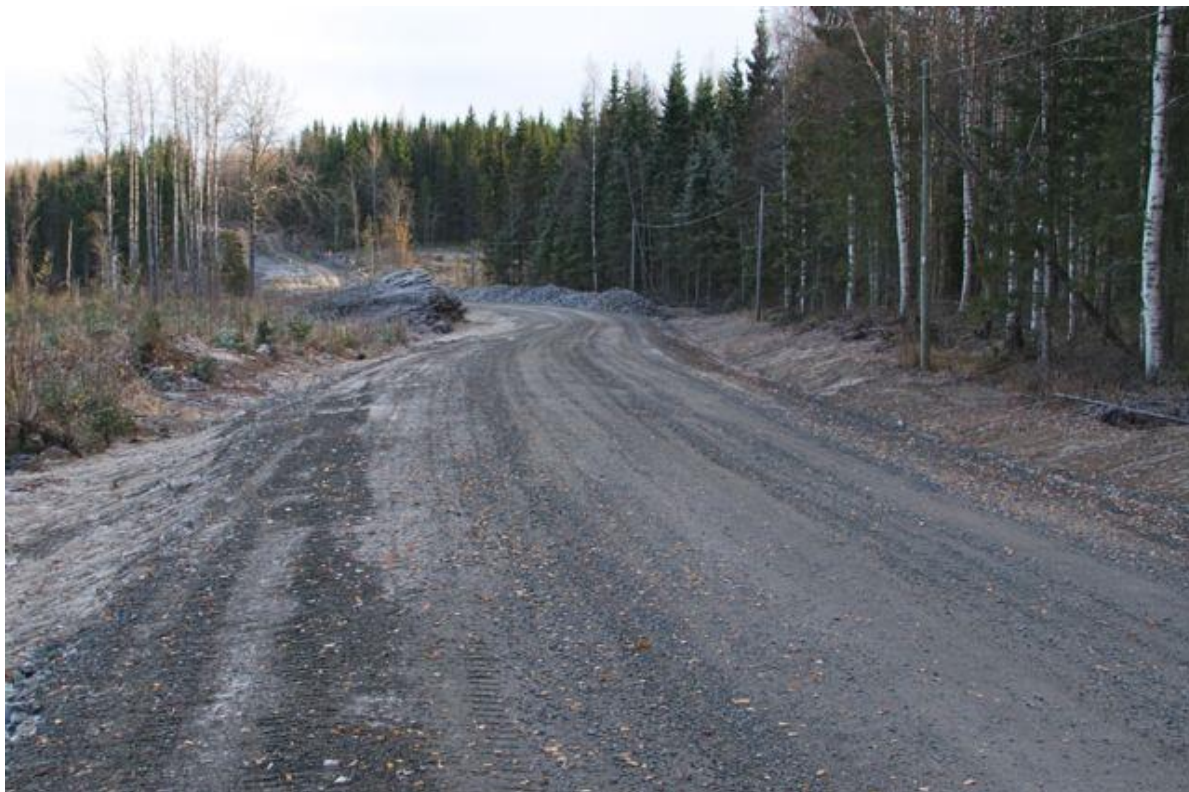
Kuva 9 Tiivistetty ja muotoiltu tie. Kauempana näkyy kivikarhoa, joka tullaan sekoittamaan tienruntoon. (Kuva Juha Kuusjärvi 2010).
