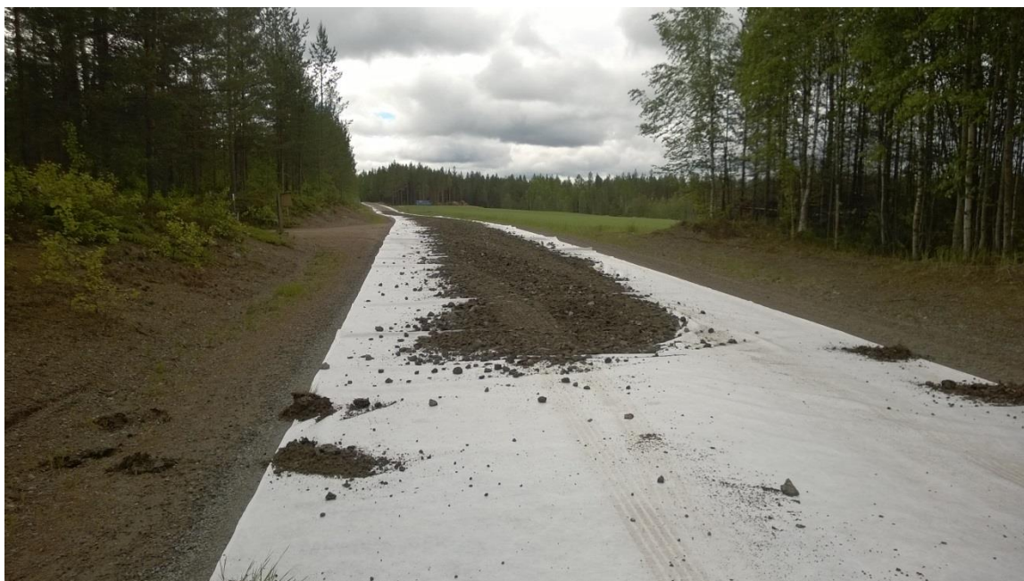
Kuva 7 Vanhan tierakenteen päälle on levitetty suodatinkangas ja sen päälle tehdään kantava kerros (200 - 300 mm) levittämällä murske kerroksittain (rakeisuus #0 - 55 mm). (Kuva Juha Partanen 2014).
