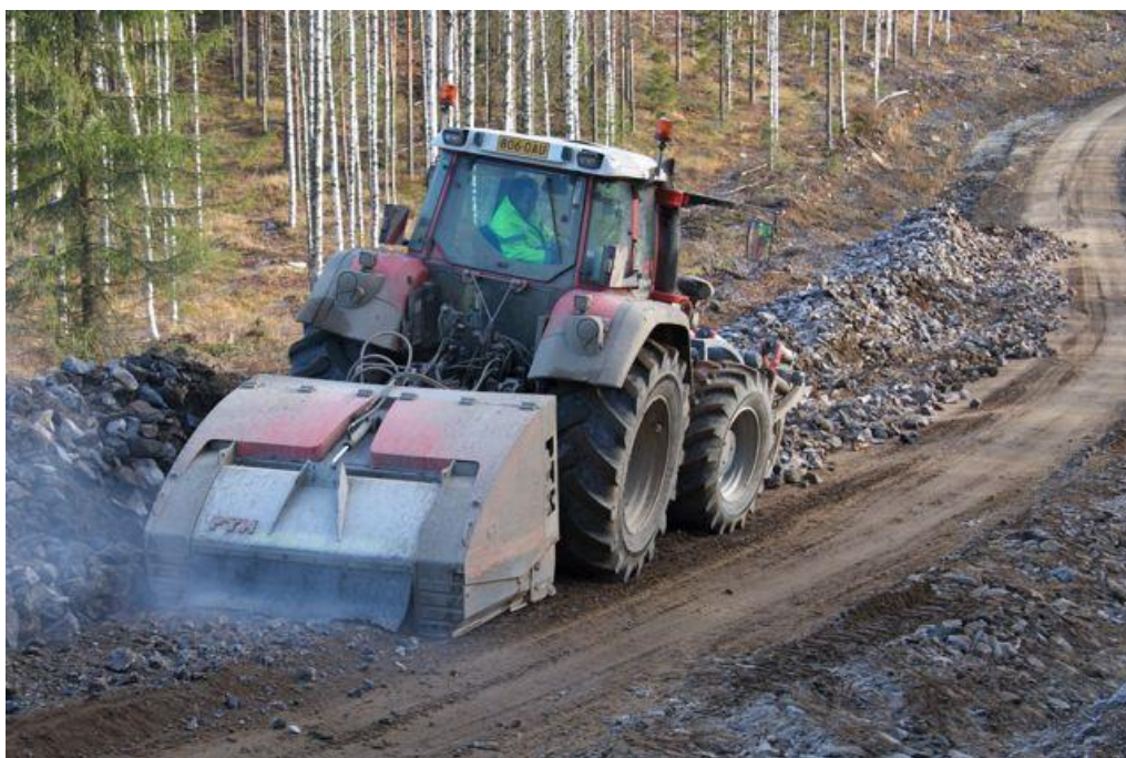
Kuva 8 PTH-Chrusher -kivijyrsin ja murskattavaa kiviainesta. (Kuva Juha Kuusjärvi 2010).
