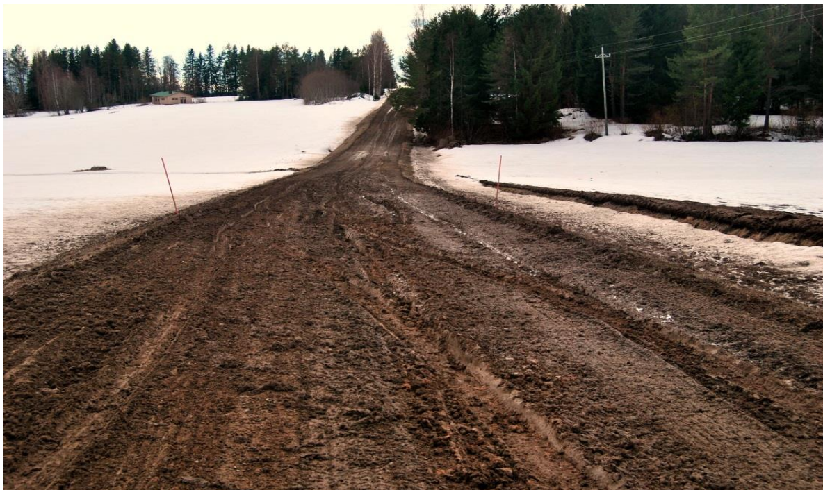
Kuva 3 Soratien runkokelirikkoa keväällä 2015. (Kuva Henna Vauhkonen 2015).
