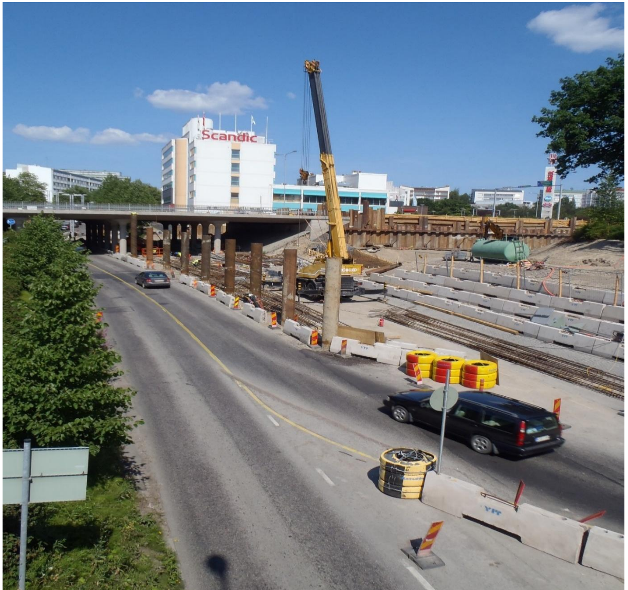
KUVA 6. Terminaalikannen välituen porapaalut (Poutanen 2014)
