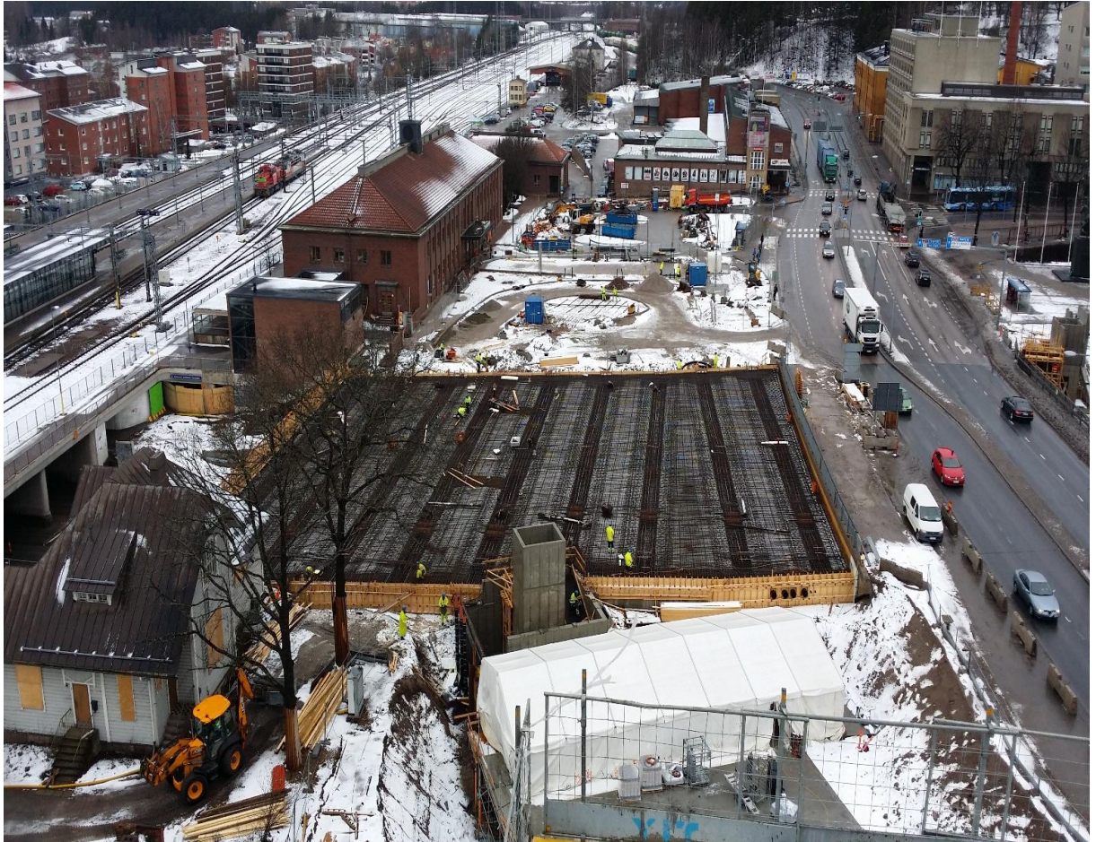
KUVA 3. Terminaalikannen raudoitus BW-Towerin katolta kuvattuna (Rekola 2015)
