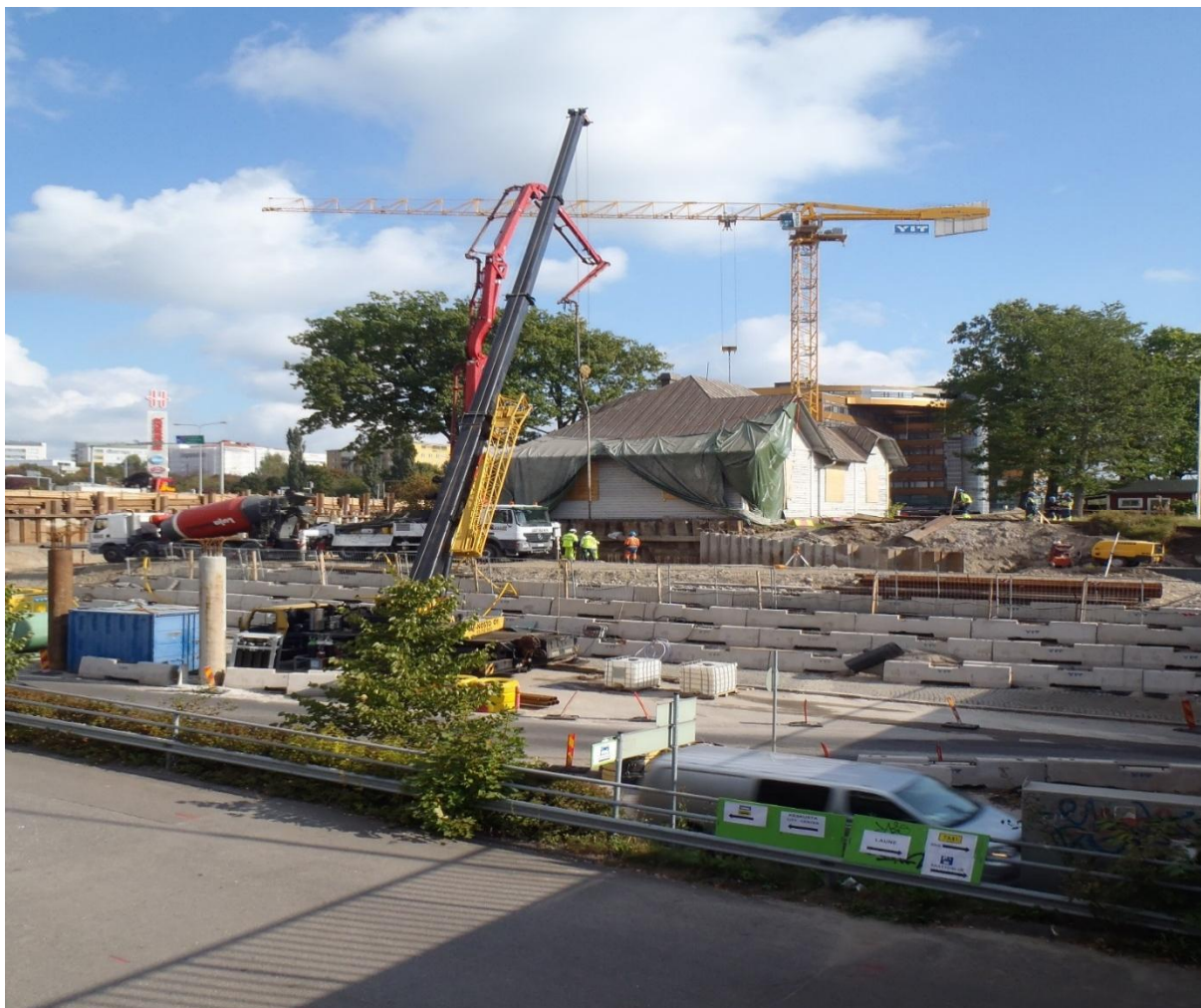
KUVA 8. Työnaikainen maanpainesinä betoninorsuista (Poutanen 2014)
