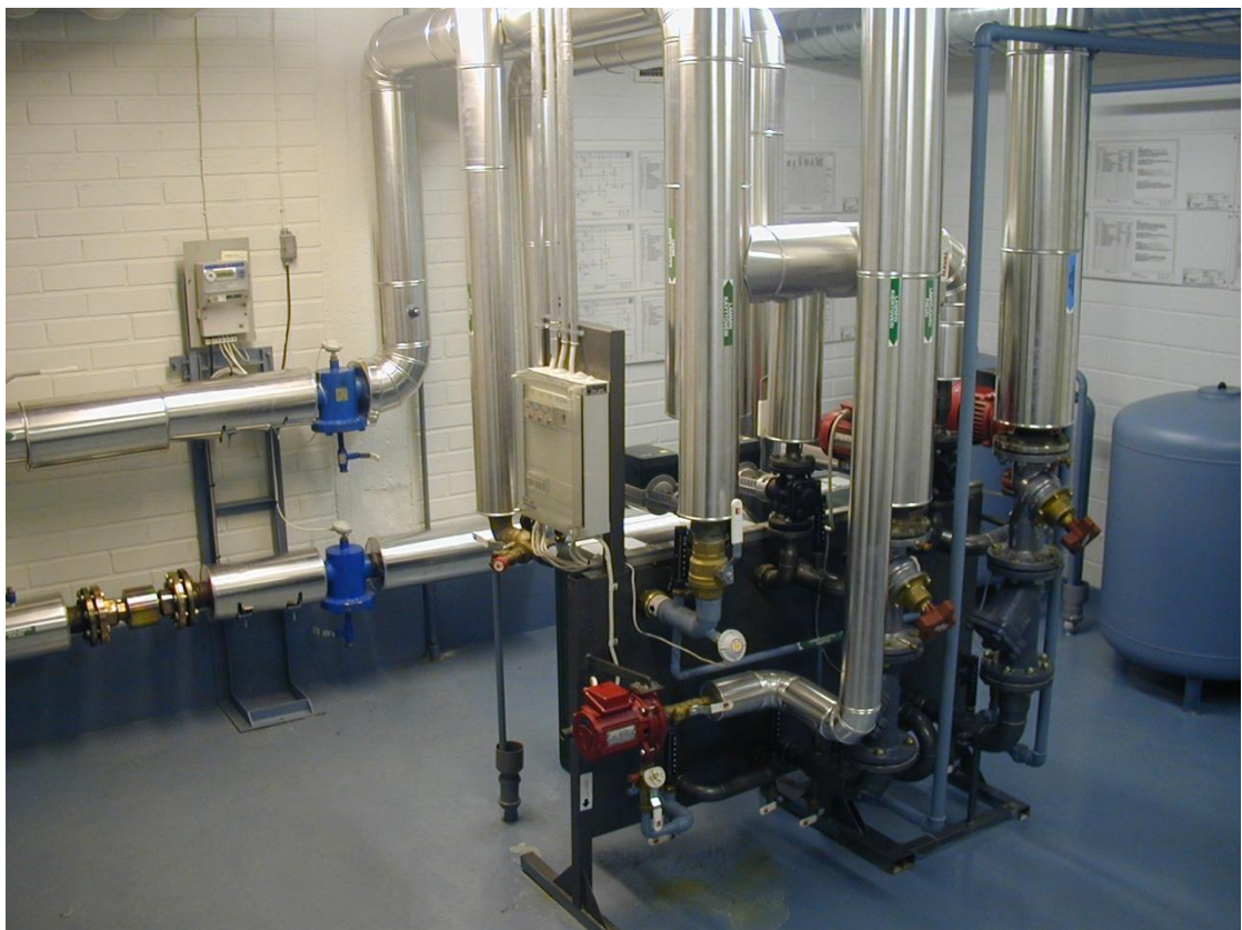
Kuvio 16: Kaukolämpölaitteet lämmönjakohuoneessa
