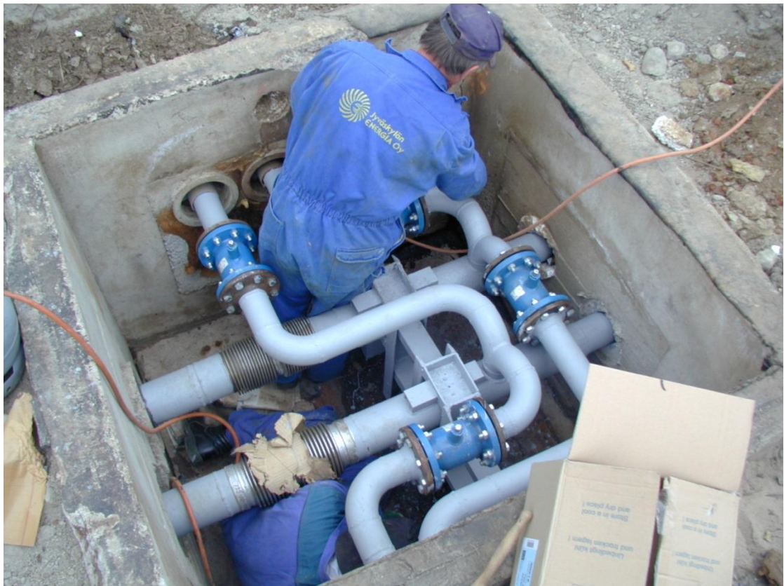
Kuvio 5: Betonikaivon paljetasaimet, venttiilit ja kiintopiste
