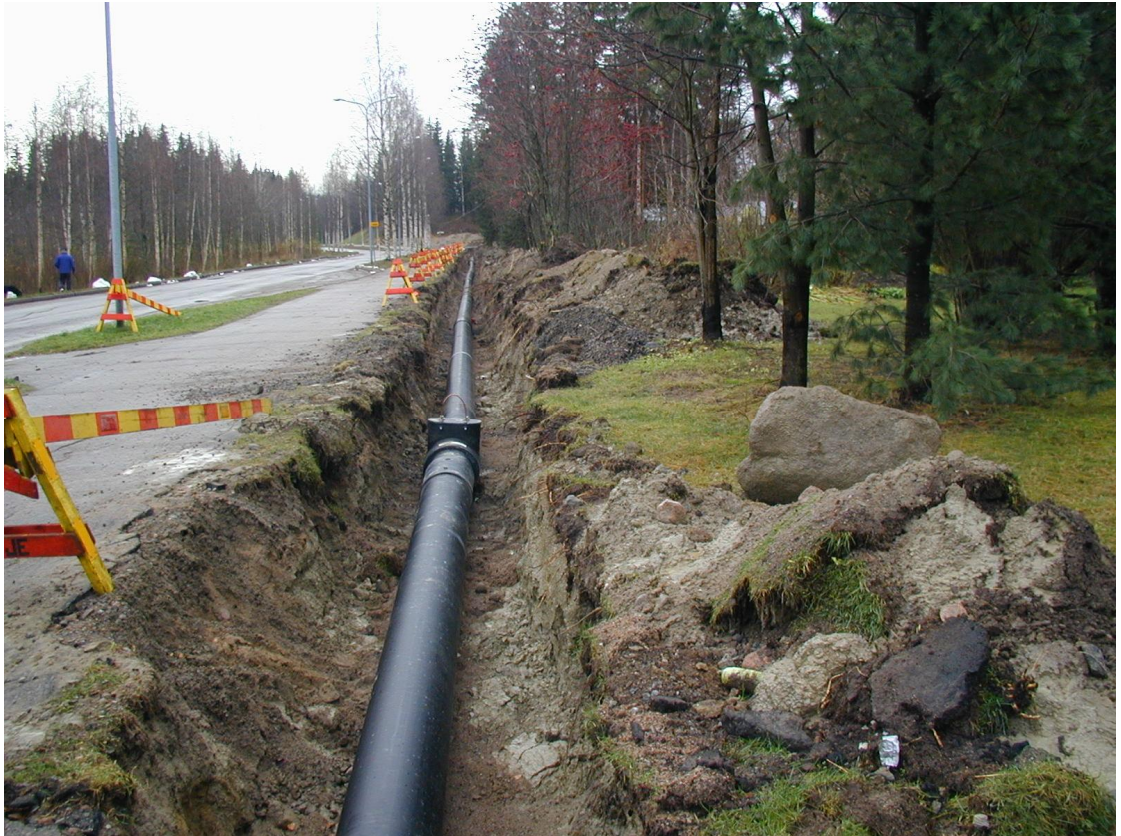
Kuvio 3: Mpuk kaukolämpöjohto kaivannossa
