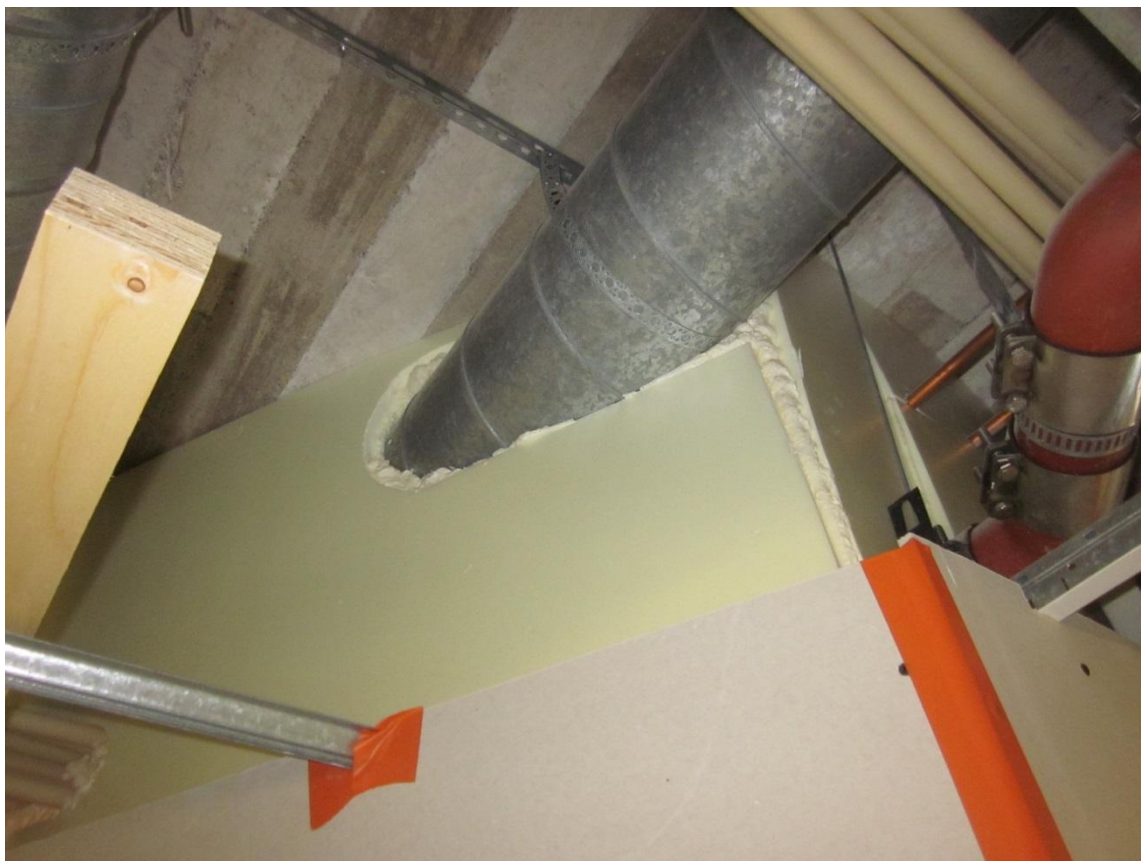
Kuva 1. Suojaseinän tiivistäminen läpivientien ja levysaumojen kohdilta. Kuva Kylliäinen, Juho.
