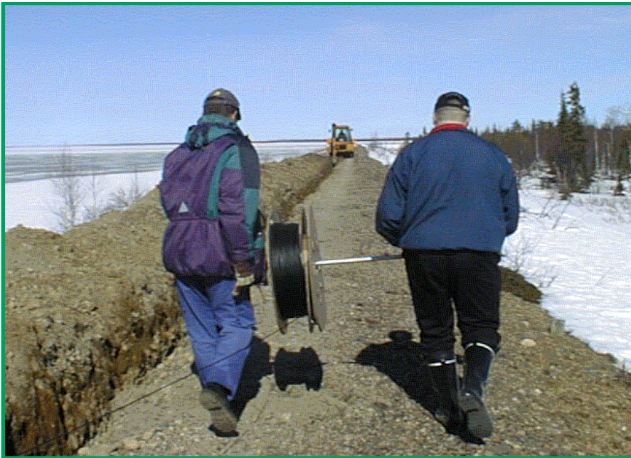
KUVA 8. Valokaapelin asentamista Porttipahdan maapatoon (19, s. 10)
