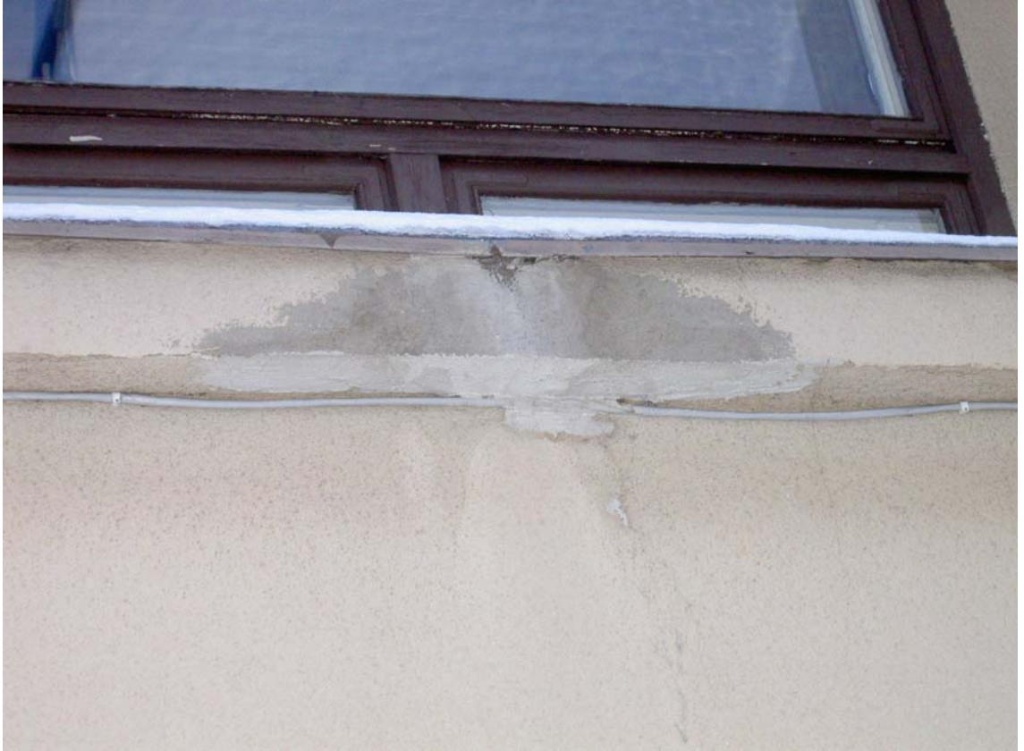
Kuva 7. Paikattu ikkunapenkki
