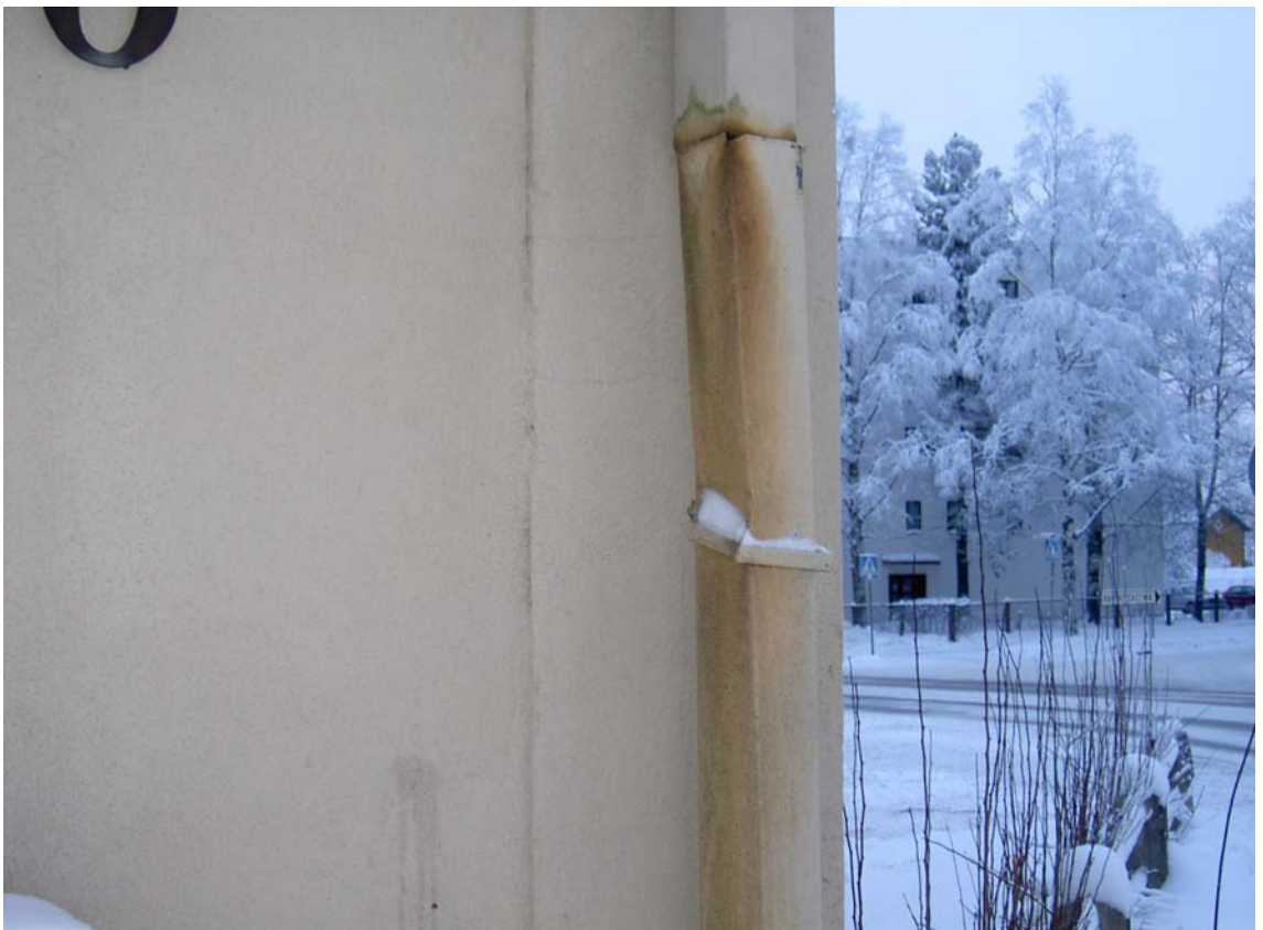
Kuva 8. Syöksytörvien vaurioita
