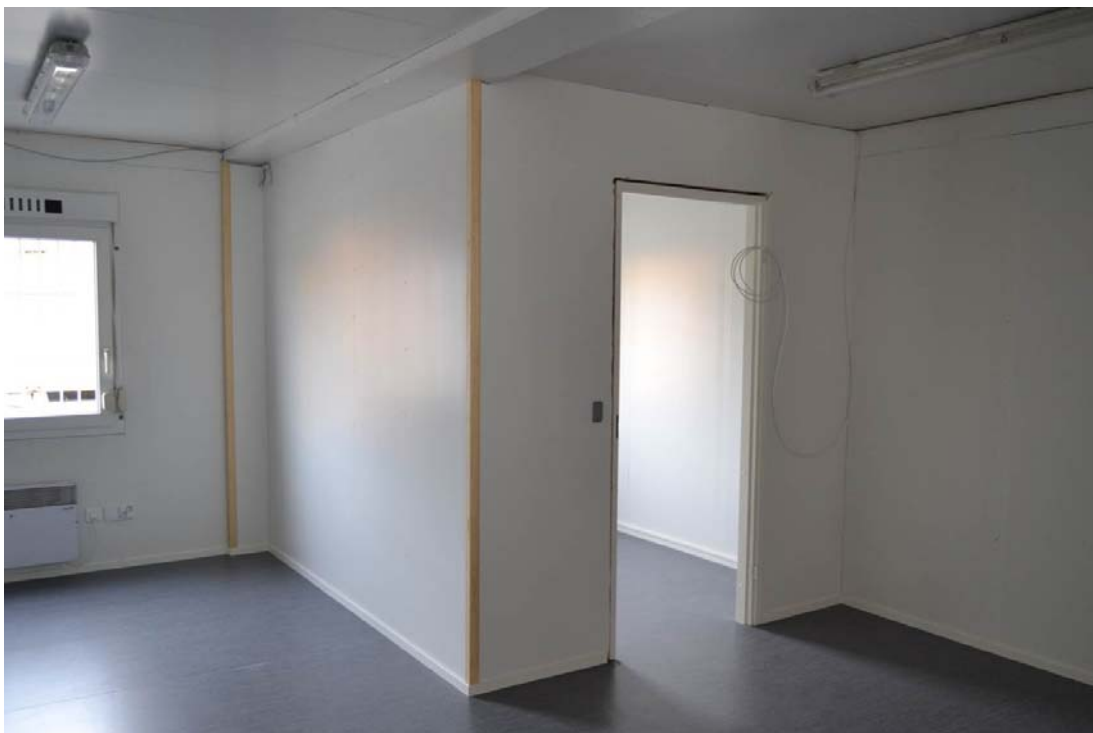
Kuva 2. Kulissikaupungin myymälän sisäkuva ja paikalla rakennettu väliseinä.
