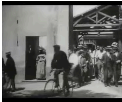
KUVA 1. Still-kuva dokumentista Työläiset poistuvat Lumièren tehtaasta Lyonissa
