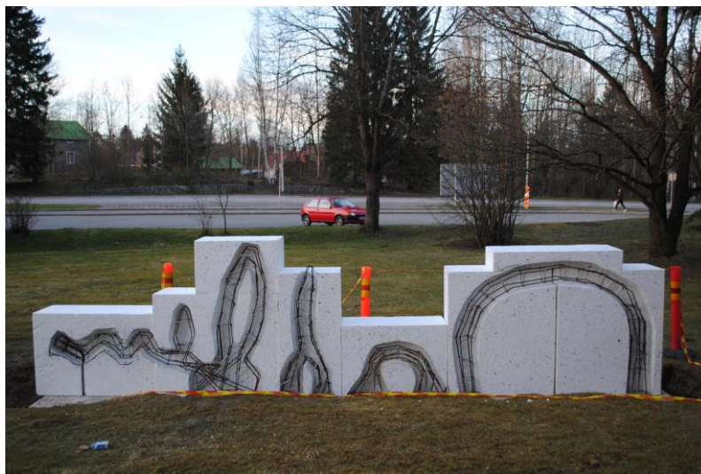
Kuva 4. Raudoituksen tulee sopia muottiin niin, että suojaväli valun pinnasta raudoitukseen pintaan on 3,5-5mm.
