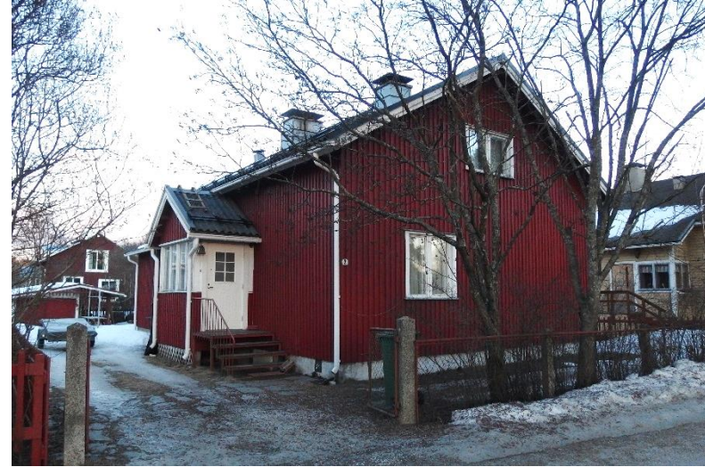
Kuva 17. Rintamamiestalon julkisivu kadulle päin pääsisäänkäynteineen.
