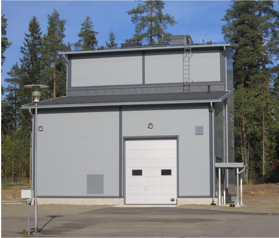
Kuva 1. Energiatutkimuskeskus. Kuva ulkopuolelta.
