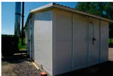
Tutkintakohde vasemmalta takakulmasta
