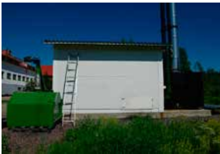
Tutkintakohde oikealta sivulta
