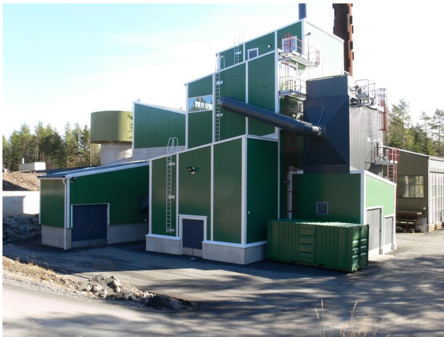
Kuvio 1. Ahjolan kaukolämpölaitos
