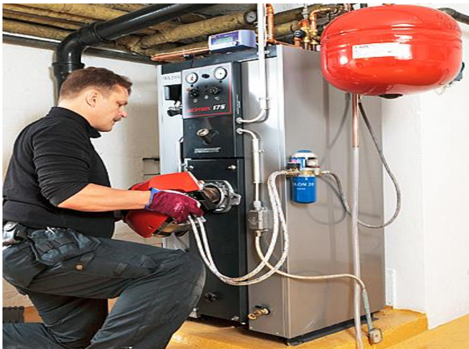
KUVA 2. Polttimen asennus uuteen öljykattilaan (Energiatehokas koti 2012.)
