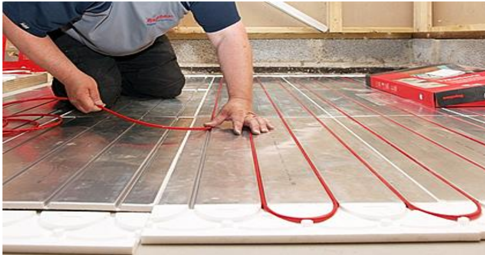
KUVA 1. Lattialämmityskaapelin asennusta lämmönjakolamelliin (Energiatehokas koti 2013.)
