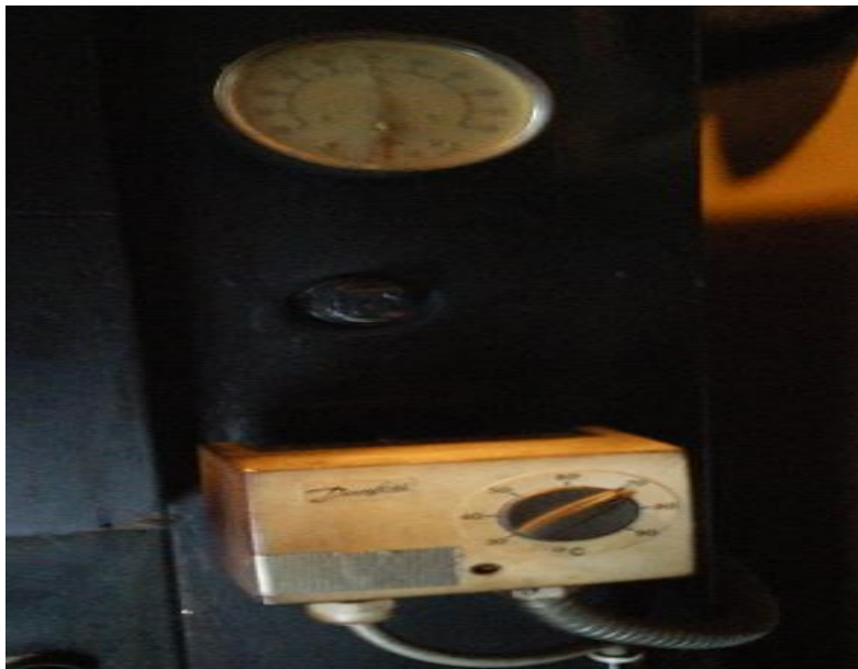
KUVA 13. Öljykattilan termostaatti ja lämpömittari (Kärkkäinen 2015-04-08.)
