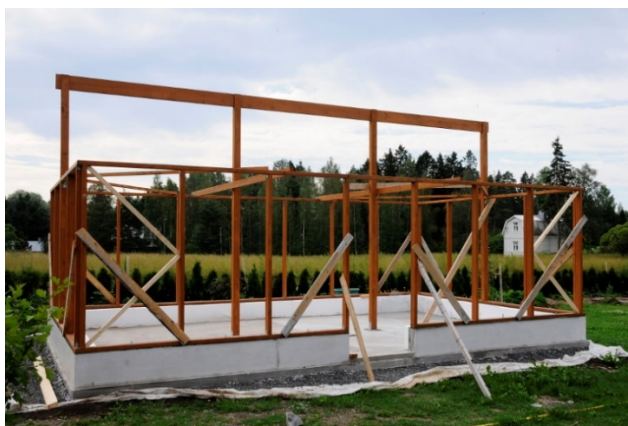
KUVA 10. Porvoon kasvihuoneen rakentamista. (Rakennuttajan kuva.)
