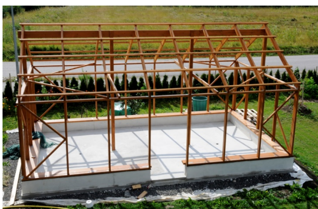
KUVA 11. Porvoon kasvihuoneen runko valmistumassa. (Rakennuttajan kuva.)
