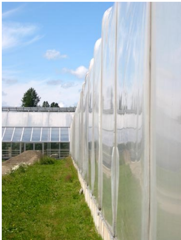
KUVA 2. Kasvihuonemuovi katemateriaalina kasvihuoneessa. (Oy Steelmark Ab)
