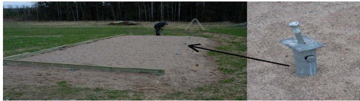
KUVA 4. Ruuvipaaluperustuksien asennusta. (Yksityinen kuva-albumi)
