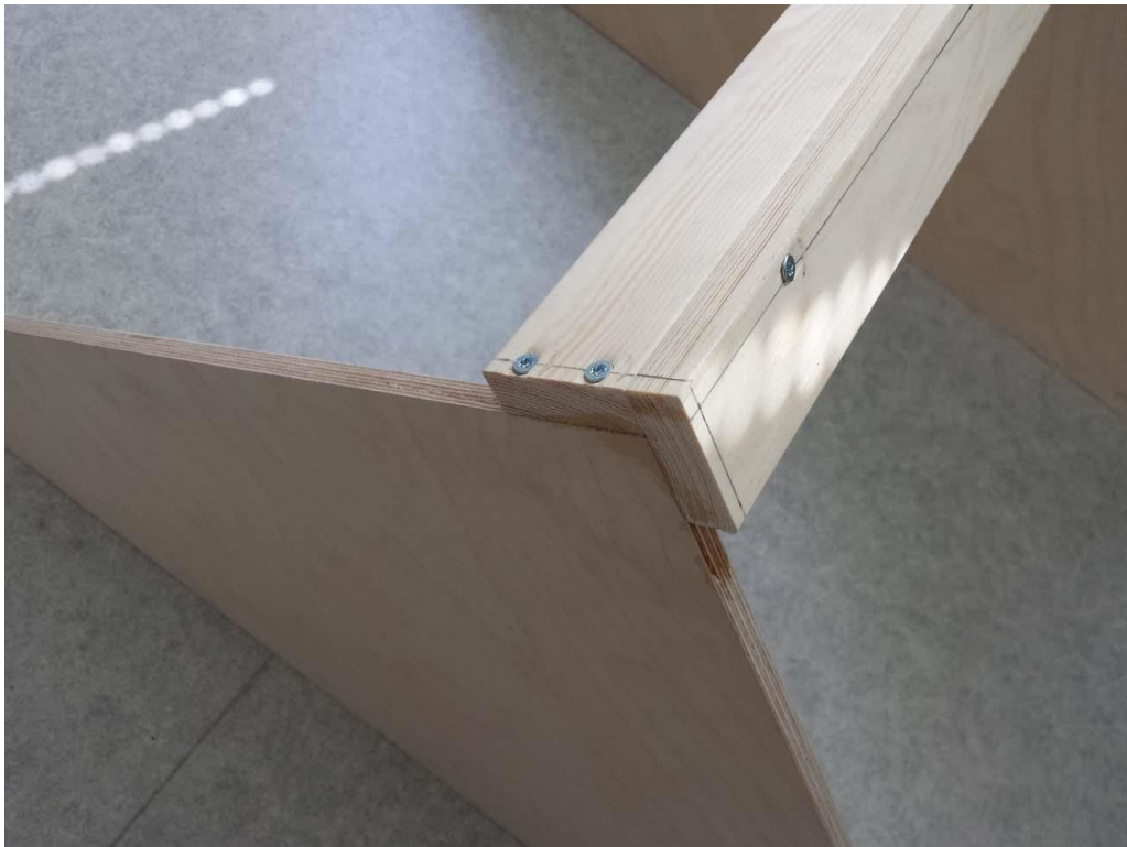
KUVA 8. Bassoansan kehyksen liitoskohta (Kuva: Mikael Sjöman 2013)
