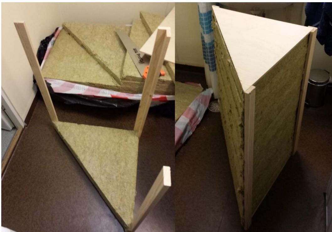
KUVA 11. Bassoansan täyttäminen eristemateriaalilla (Kuva: Mikael Sjöman 2013)
