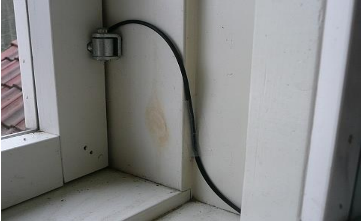
Kuva 16. Antennikaapelin vienti sisätiloihin läpivientikaapelilla (Mobile Evolution [Viitattu 11.4.2015]).
