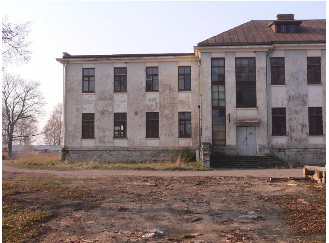
Kuva 4. Tämän hetkinen pääsisäänkäynti /kuvannut Heidi Jantunen/
