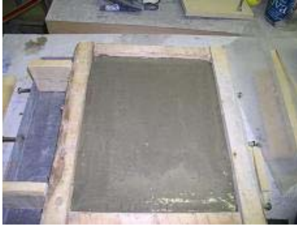
Kuva 27. loppuun valettu laatta
