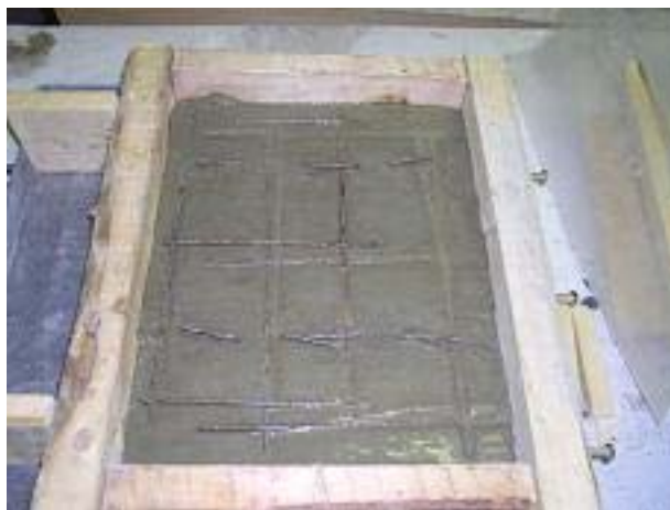
Kuva 26. valuun asennettu neljän millimetrin teräsverkko
