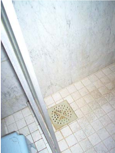
Kuva 24. Suihkukaapin lattiakaivo
