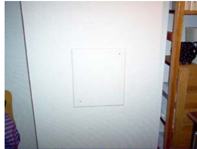
Kuva 19. Aputilassa sijaitsee talon päävesisulut, myös pihasaunan osalta.
