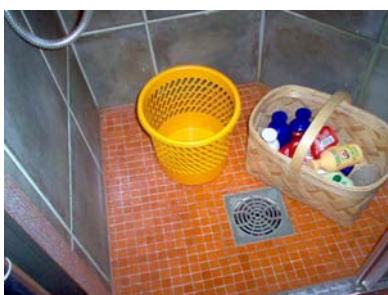
Kuva 6. Kylpyhuoneen suihkukaapin lattiakaivo
