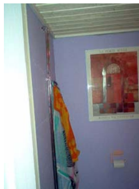
Kuva 10. Aputilan wc:n käyttövesiputkien läpiviennit
