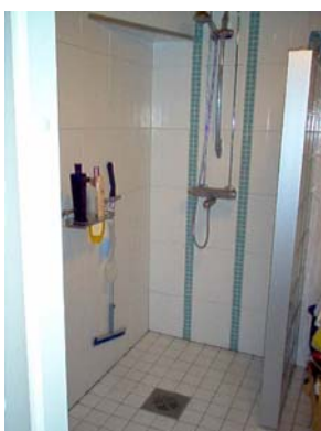
Kuva 35 Aputilojen saunan pesuhuone
