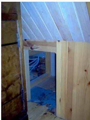
Kuva 52. Yläkerran rappujen alla huoltoluukku
