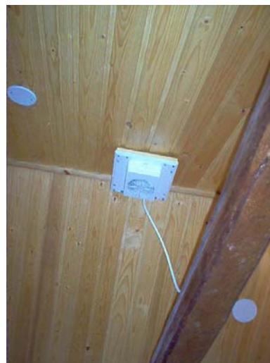
Kuva 48. Poistoilmapuhallin
