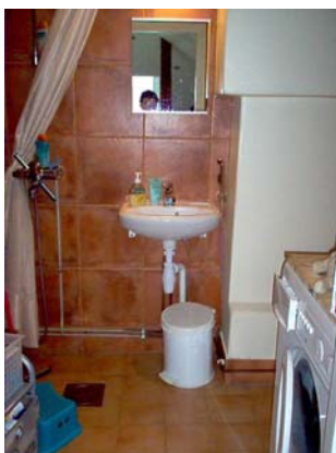
Kuva 55. Aputilojen wc:n pesuallas ja suihkunurkkaus
