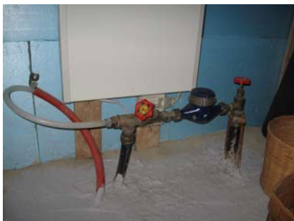
Kuva 20. Talon päävesimittari sijaitsee huoneiston A2 puolilämpimässä varastotilassa.
