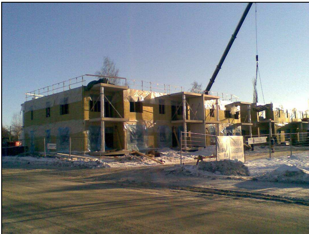
Kuvio 16: Näkymä työmaalle Kuoppamäentieltä – elementtien pinnassa ensimmäinen eristekerros, jonka myöhemmin peittää toinen villakerros ja rappauspinta
