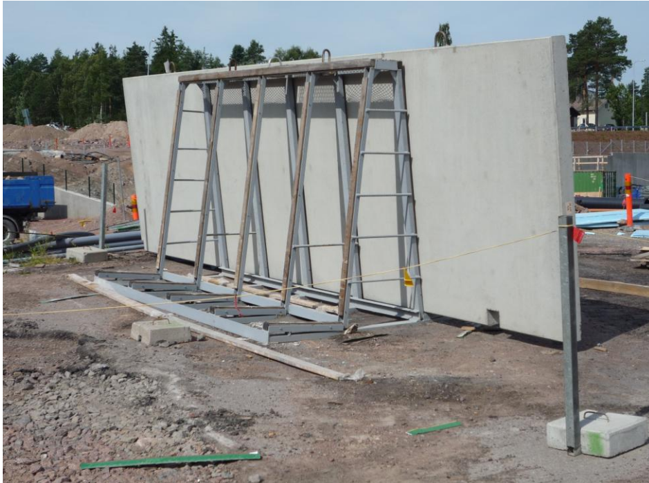
Kuvio 9: Elementti varastoituna a-pukkiin
