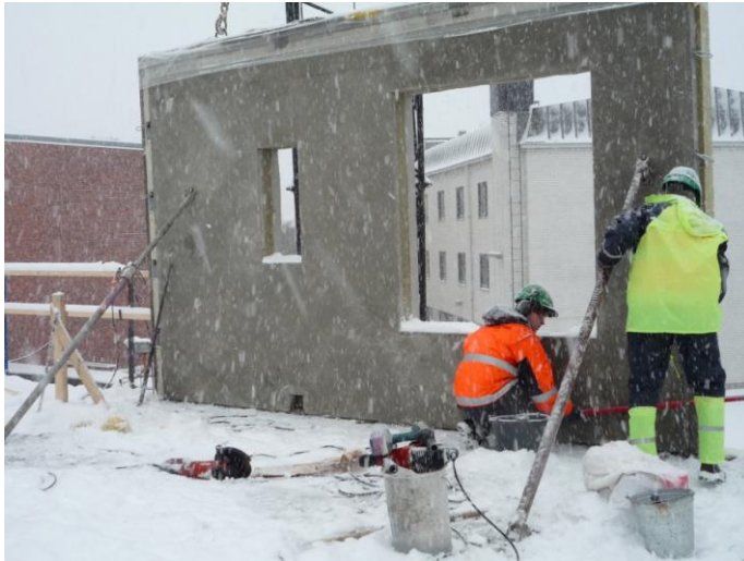
Kuvio 23: Talvirakentaminen luo haasteita työmaalle
