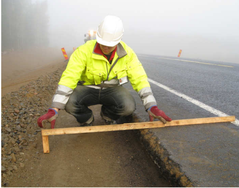
Kuva 12 Kantavan kerroksen korkeusaseman mittauksen voi tehdä yksinkertaisella ajokepillä
