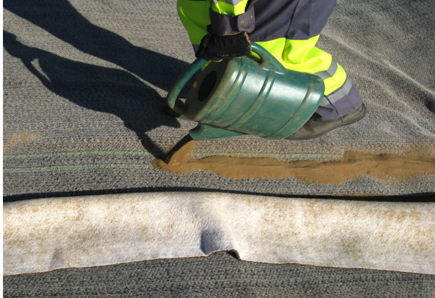
Kuva 8 Bentoniittimatton saumojen limitys varmistetaan bentoniittijauheella tai vaihtoehtoisesti voidaan käyttää myös bentoniittipastaa.
