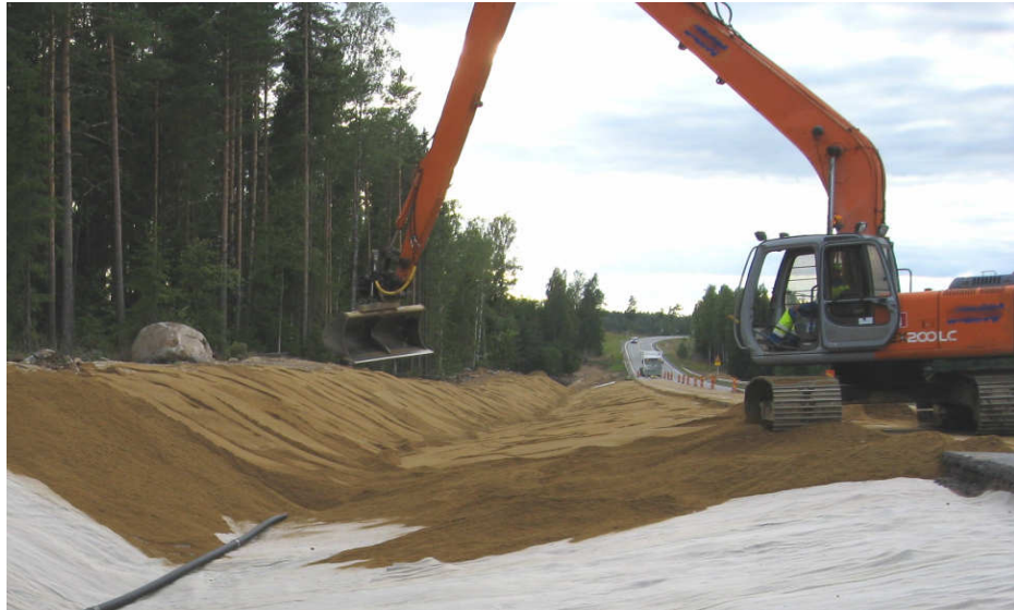
Kuva 14 Pitkäpuominen kaivinkone bentoniittimattoa peittämässä. Tekemällä ”hiekkapeti” koneen telan alle saadaan lisää ulottuvuutta
