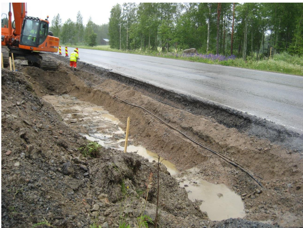
KUVA 2. Maantien rakennekerrokset esillä
