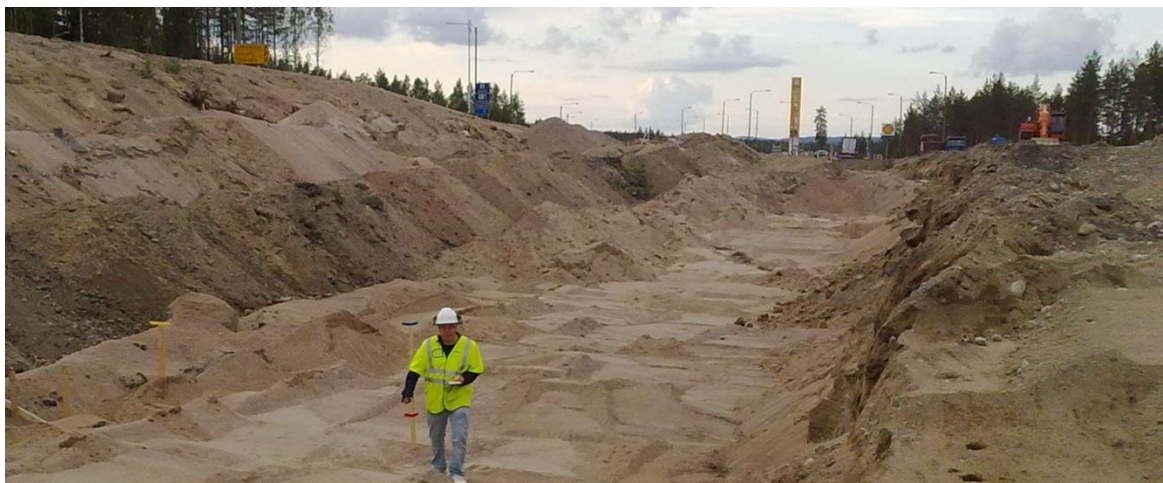
KUVA 8. Suodatinhiekkakerroksen mittaus käynnissä (Halonen, 2011)
