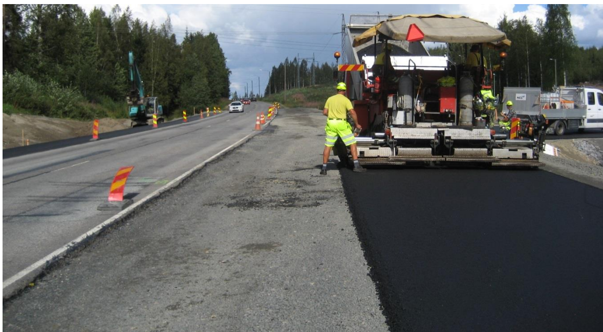
KUVA 3. ABK -asfalttimassan levitystä
