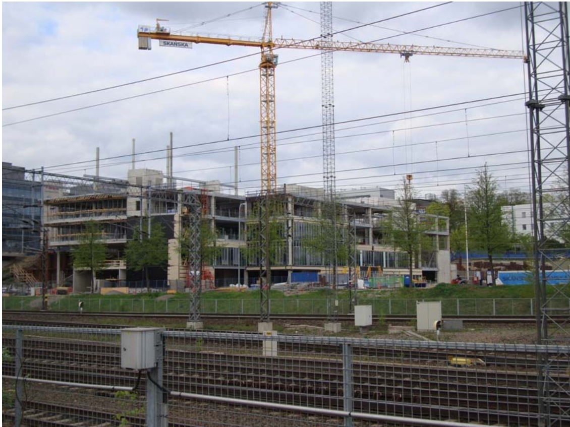
Kuvio 12: Technopolis Yliopistonrinteen työmaa.
