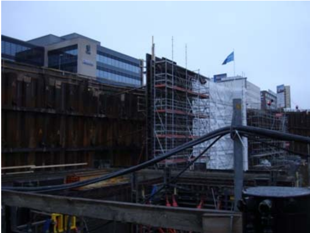
Kuvio 11: Maanpainesseinän rakennusta ja työnaikainen ponttiseinä.
