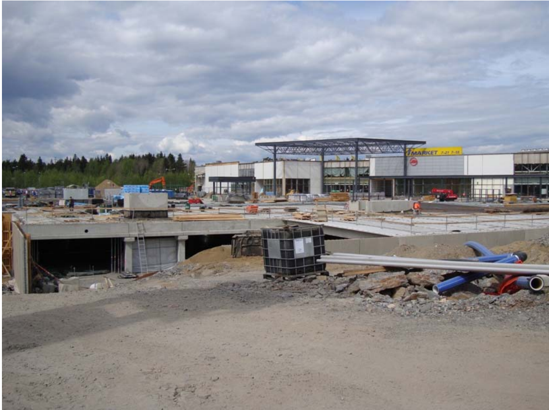
Kuvio 9: Kaupan rakennuksen työmaa esikaupunkialueella.
