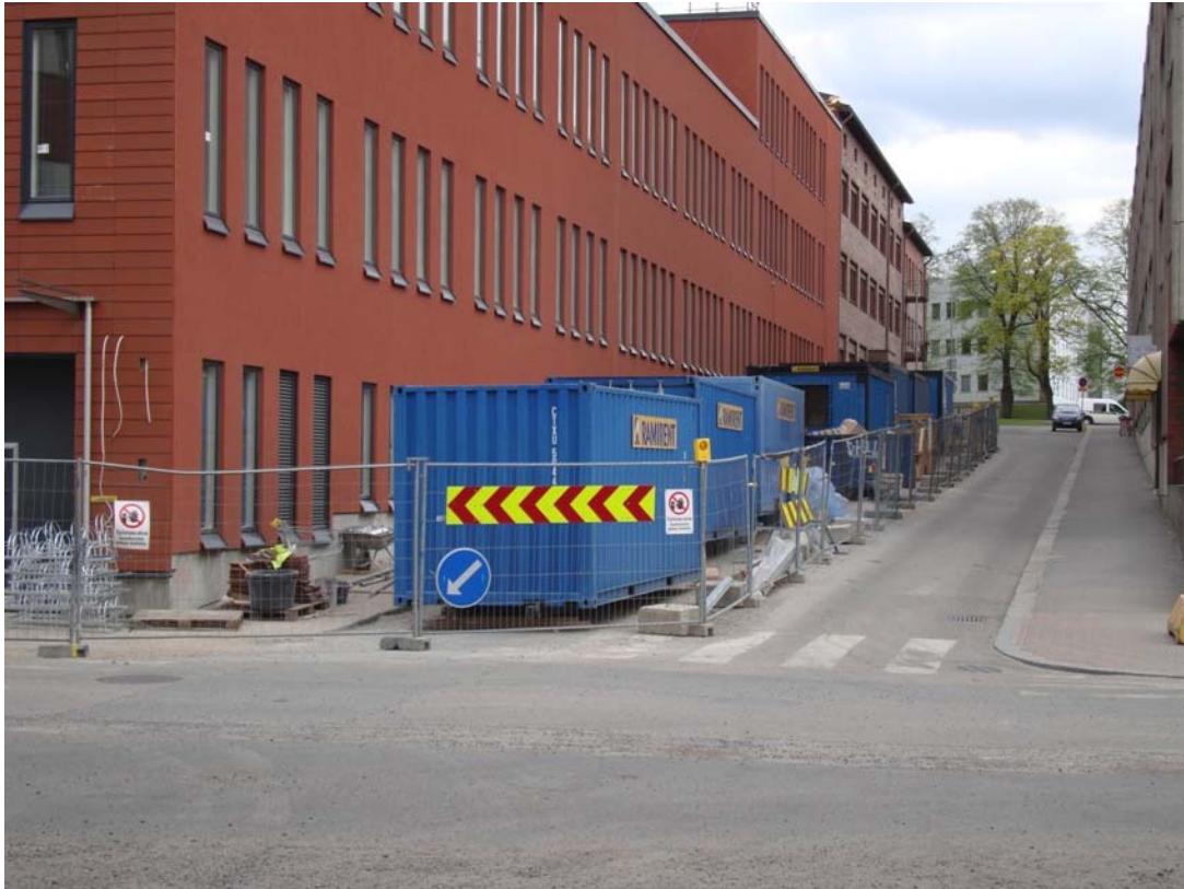
Kuvio 10: Korjausrakennuskohteet vaativat usein varastotilaa katualueilta.
