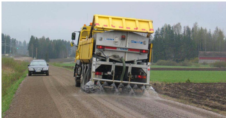
Kuva 9. Pölynsidonta liuossuolauksena. (Liikennevirasto sorateiden kunnossapito LO 1/2014, 44)
