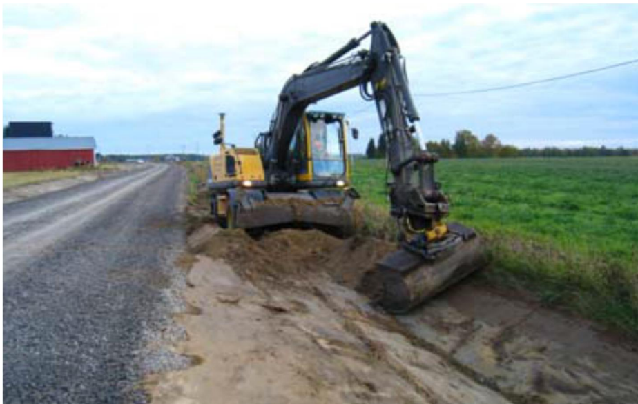
Kuva 11. Sivuojan kunnostustyö. (Liikennevirasto sorateiden kunnossapito LO 1/2014, 47)
