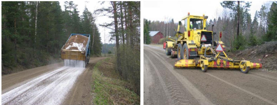
Kuva7 ja 8. Suola levitetään ja sekoitetaan, lopuksi pinta tiivistetään. (Liikennevirasto sorateiden kunnossapito LO 1/2014, 42)
