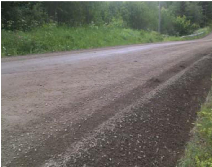
Kuva 14. Luiskasta nostettu materiaali on levitettyä tielle. (Liikennevirasto sorateiden kunnossapito LO 1/2014, 49)
