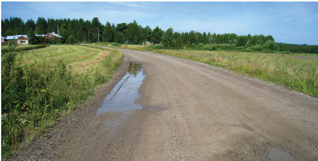
Kuva 17. Reunapalle estää veden poistumisen tieltä ja aiheuttaa vaurioita. (Liikennevirasto sorateiden kunnossapito LO 1/2014)
