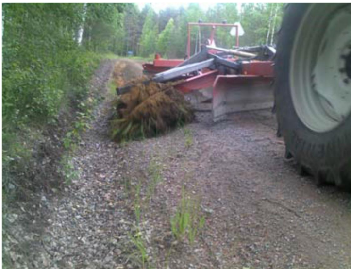
Kuva 13. Luiskasta nostetaan materiaalia tielle. (Liikennevirasto sorateiden kunnossapito LO 1/2014, 49)
