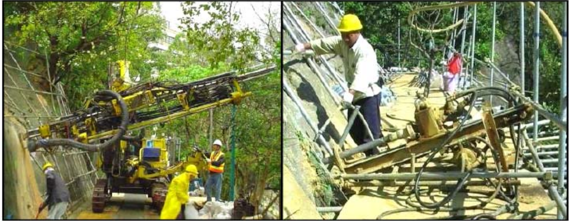
Kuvio 4: Erilaisia porauskalustoja (Application of Soil Nailing...2008)
