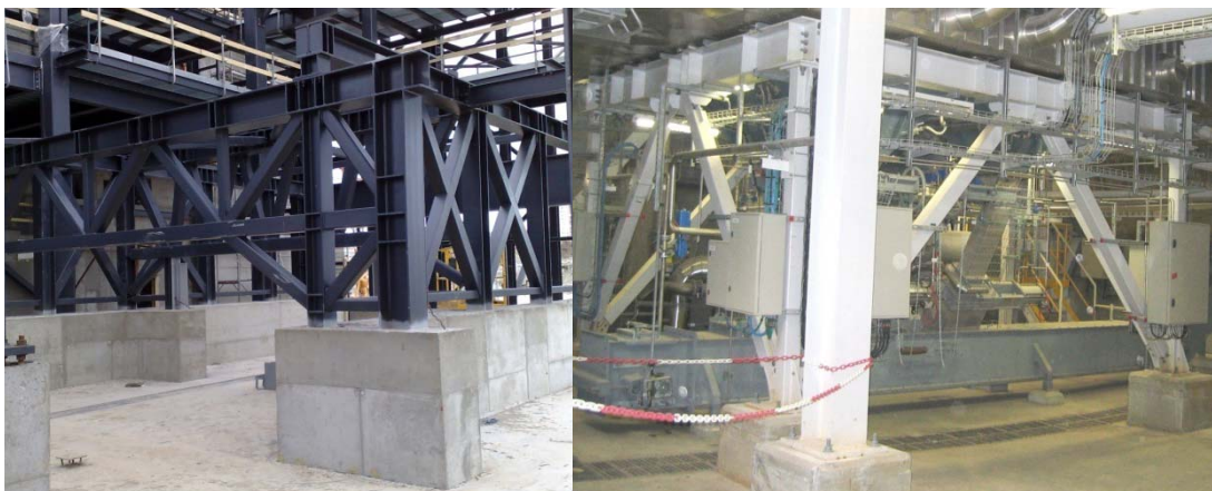
Kuvio 10. Vertailtavat kattilapukkivaihtoehdot 1 ja 2 (Valokuvat: Metso 2009i.)
