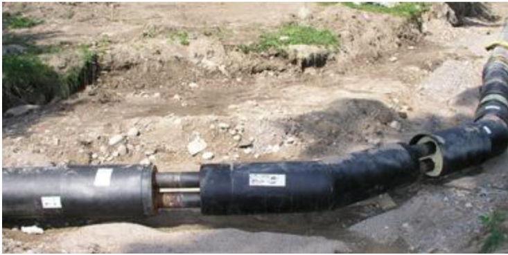
KUVA 2. Mpukin rakenne (7)
