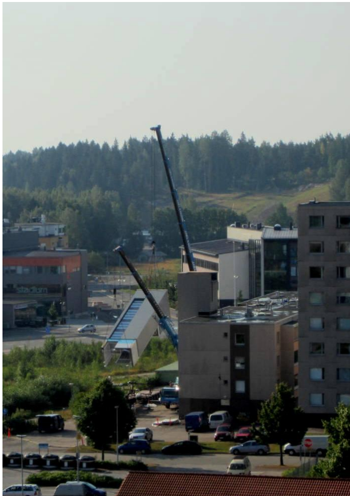
Kuva 13. Hissitorni nostetaan rekan lavalta kahdella nosturilla.
