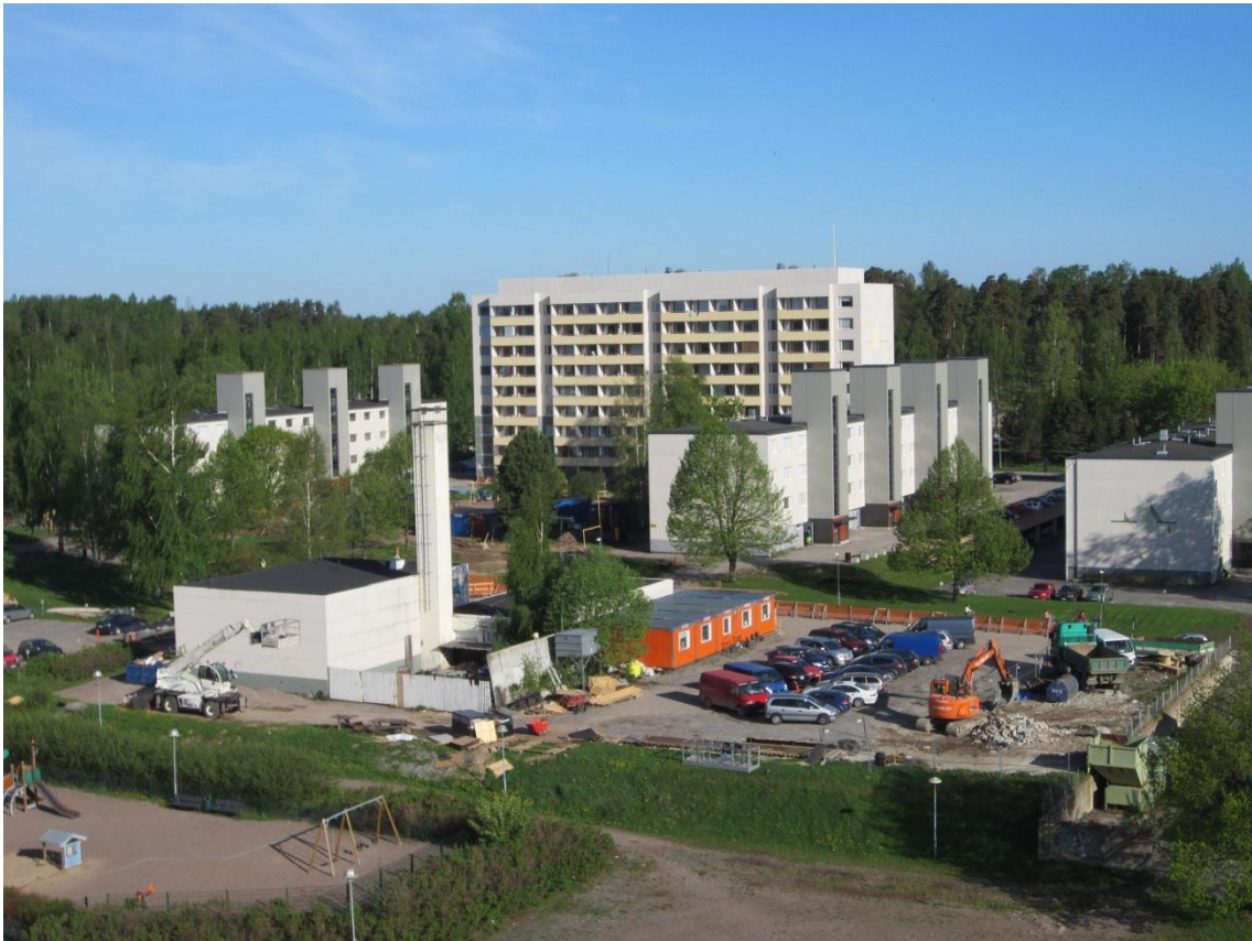
Kuva 5. Osa As. Oy Porvoonportin alueesta. Uudet hissitornit on asennettu matalien kerrostalojen ulkoseinälinjan ulkopuolelle.
