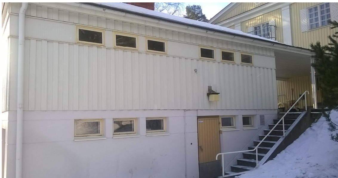
Kuva 5. Kytäjän koulu. Käynti pannuhuoneeseen.
