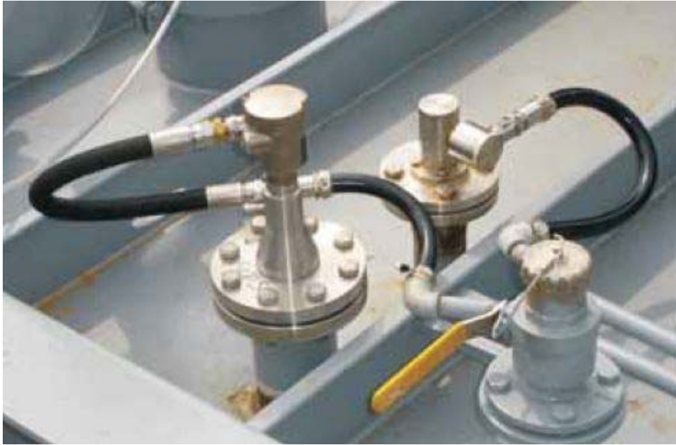
Kuva 18. Mikroaaltoihin perustuva tankkitutka (Scanjet)
