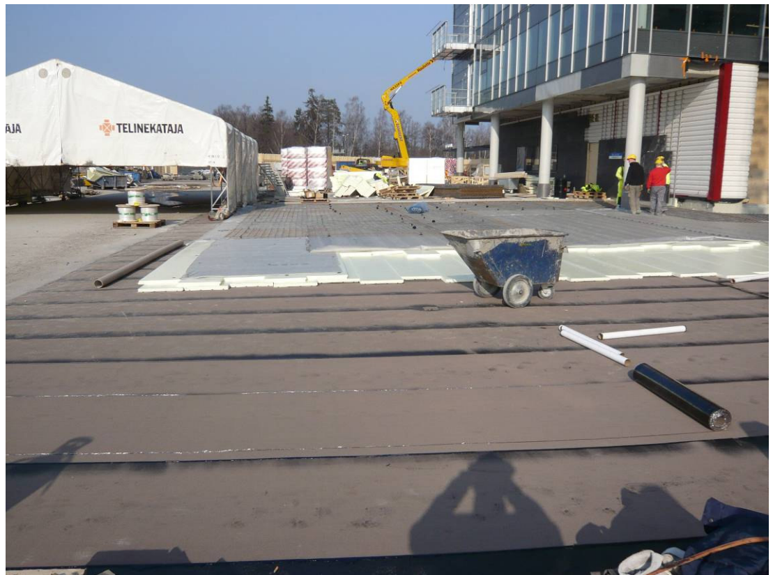
Kuva 6 Pihakannen eristystä ja suojabetonointityön valmistelua.
