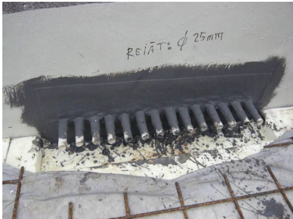
Kuva 9 Ajoluiskan lämmityskaapelien läpimenokohta vahvistettuna Triflex-vedeneristeellä.
