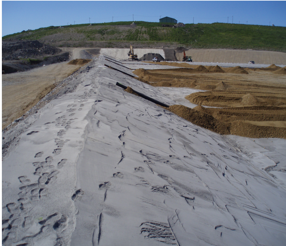
Kuva 6. Kuivatuskerros ja huuhteluputkisto.
