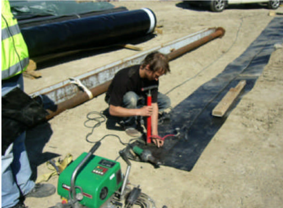
Kuva 22. Koesauman koepaineistamista.
