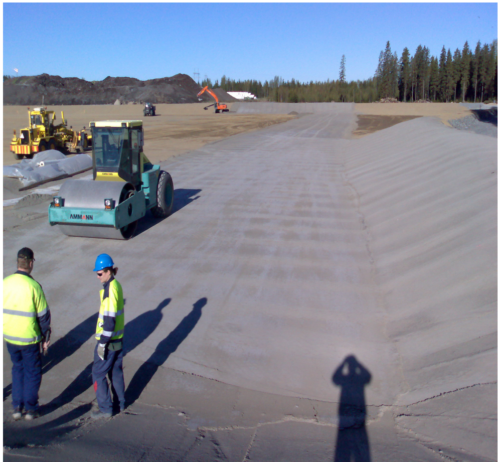
Kuva 3. Mineraalisen tiivistyskerroksen rakentaminen.
