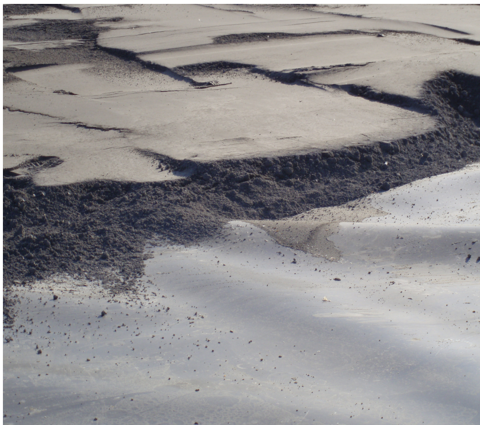
Kuva 4. Geomembraani ja suojakerros kivituhkasta.
