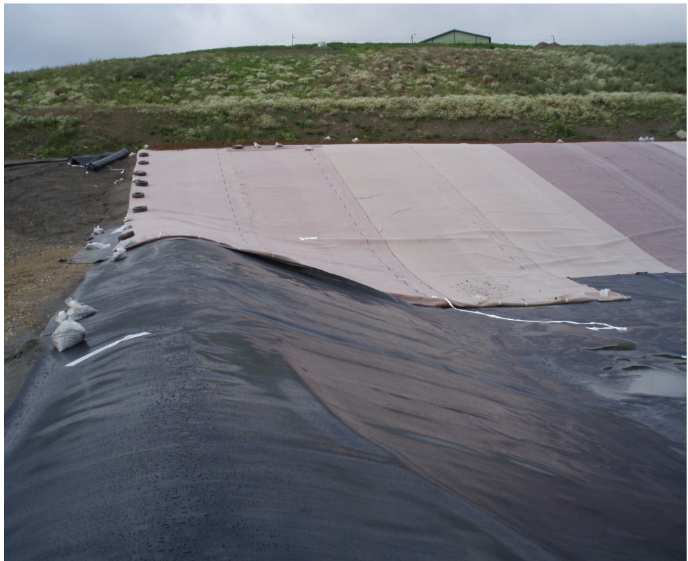
Kuva 5. Geomembraani ja suojageotekstiili.
