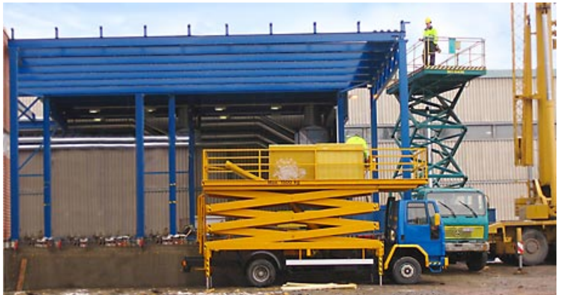
Kuva 2 Saksilava-auton käyttöä teräsrunkoasennuksessa /18/
