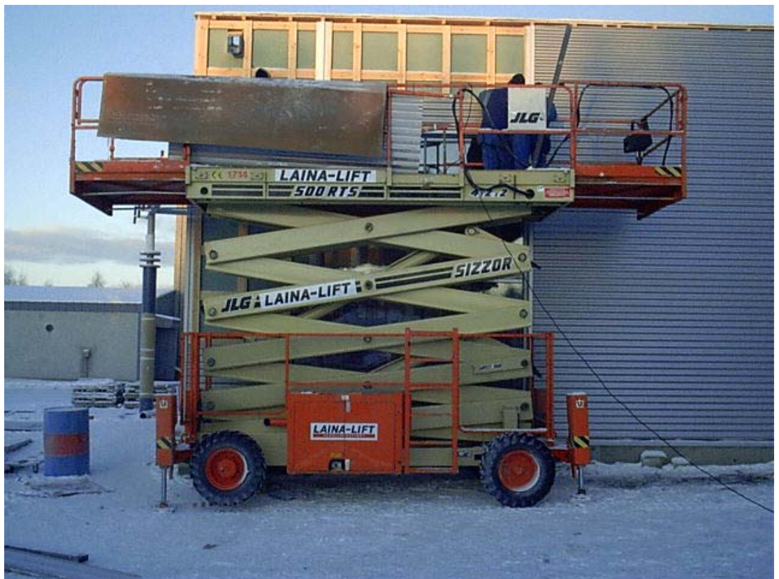
Kuva 3 Saksityölava julkisivuverhouksen asennustyössä /13/
