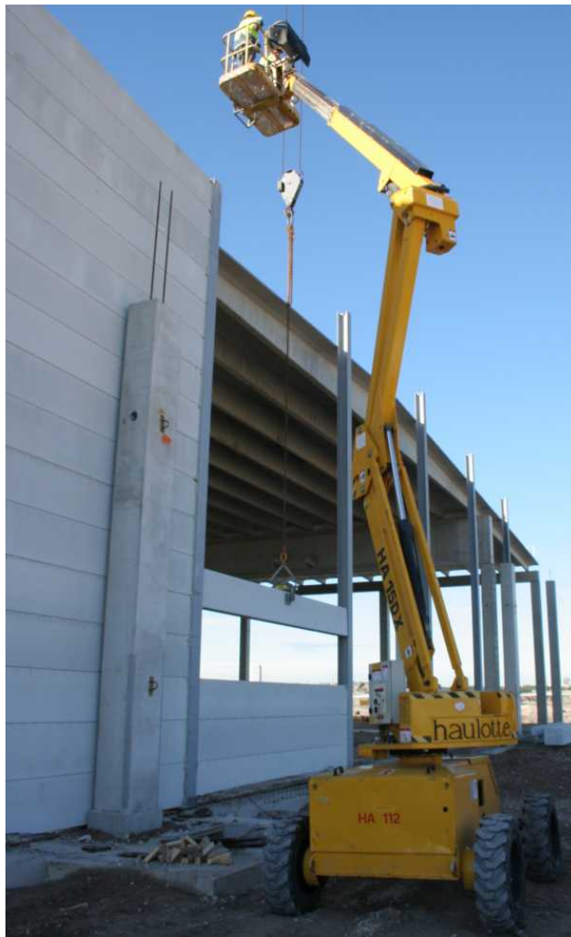
Kuva 4 Pyörialustainen kuukulkija julkisivutyössä /14/
