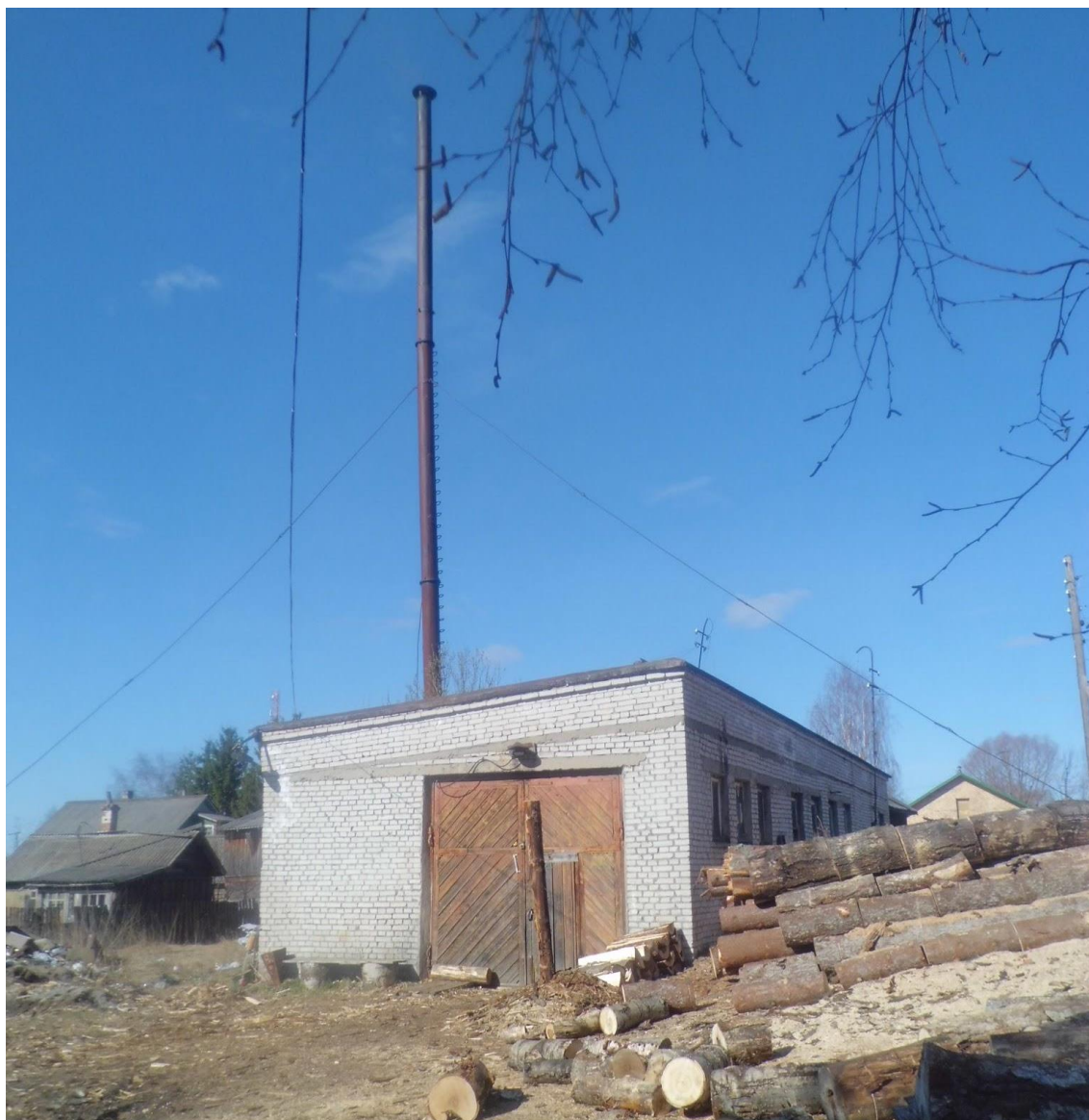
Kuva 6. Suoju-Viitanan koulun lämpölaitos.
