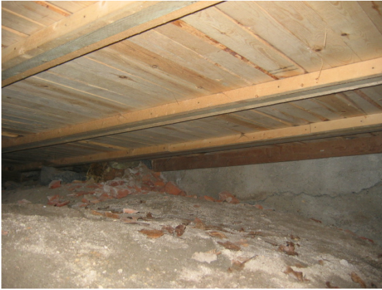
Kuva 7 ja 8. Tuulettuva tila.
