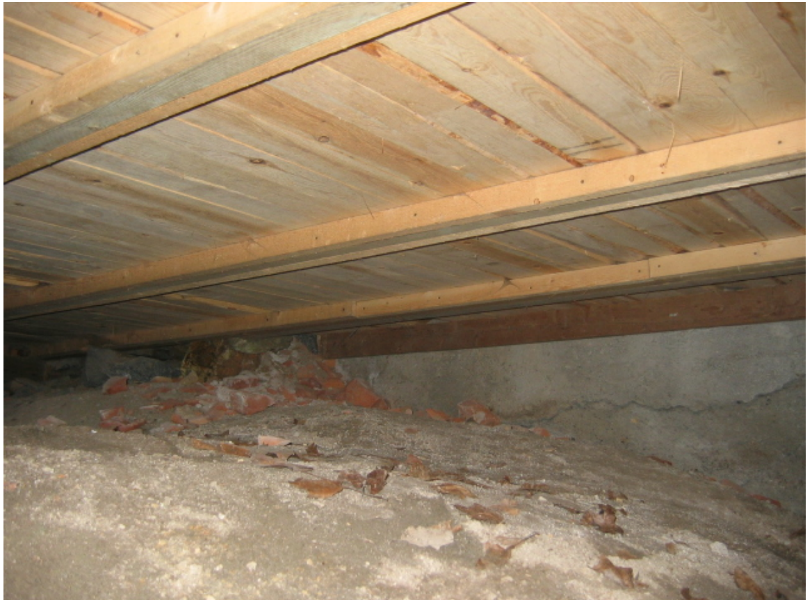
Kuva 1. Tuulettuvatila ja betonilaatan rajapinta.
