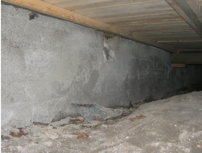
Kuva 2. Tuulettuvassa tilassa oleva hienojakoinen maa-aines.
