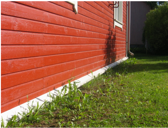
Kuva 3 ja 4. Pihamaan kallistukset viettävät perusmuuriin päin.
