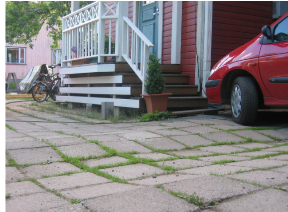
Kuva 3 ja 4. Pihamaan kallistukset viettävät perusmuuriin päin.
