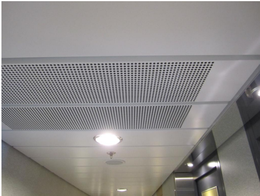
Kuva 3. Reikäpaneeli ilmastoinnin päätelaitteen kohdalla (Elomatic 2015).
