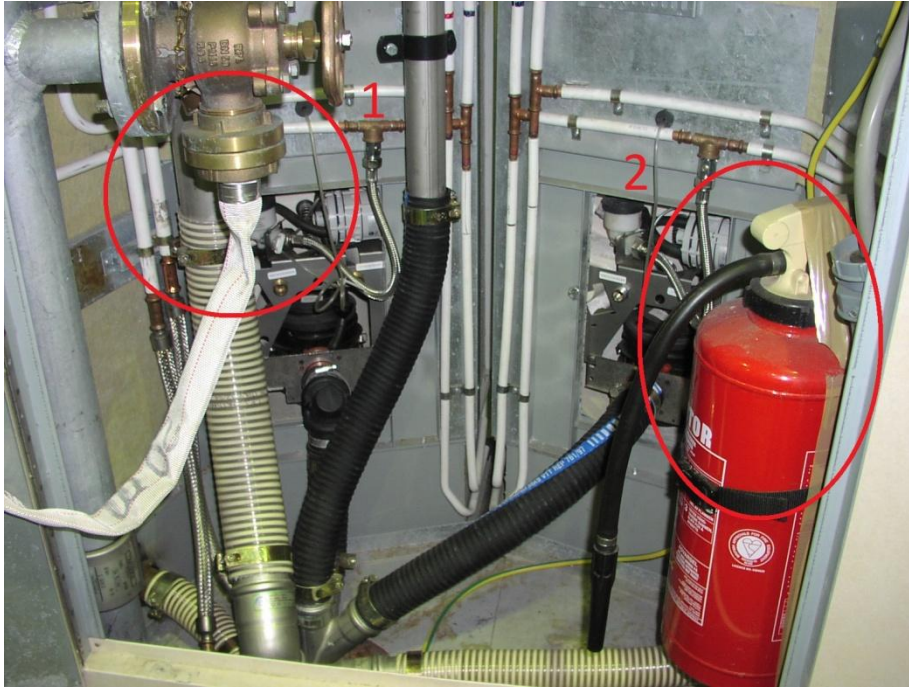
Kuva 5. Huoltokolmio, johon on sijoitettu paloposti (1) ja käsisammutin (2) (Elo-matic 2015).
