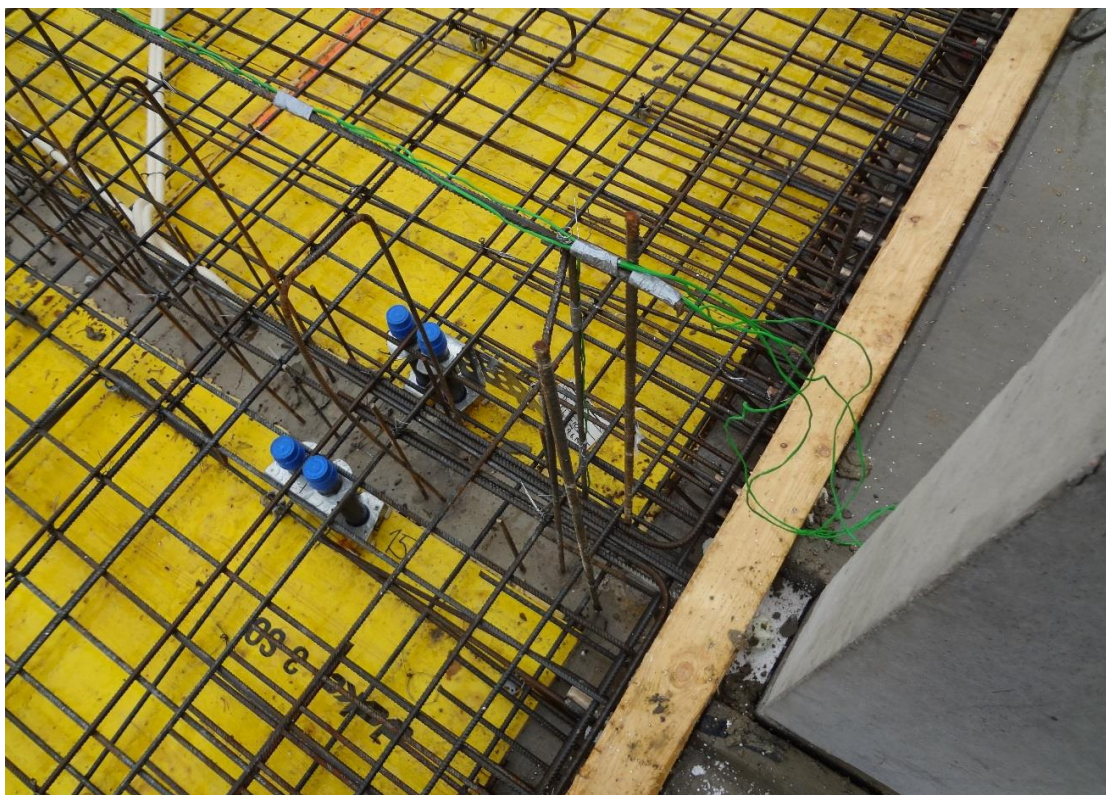
Kuva 4. Termolangat sidottu raudoitteisiin
