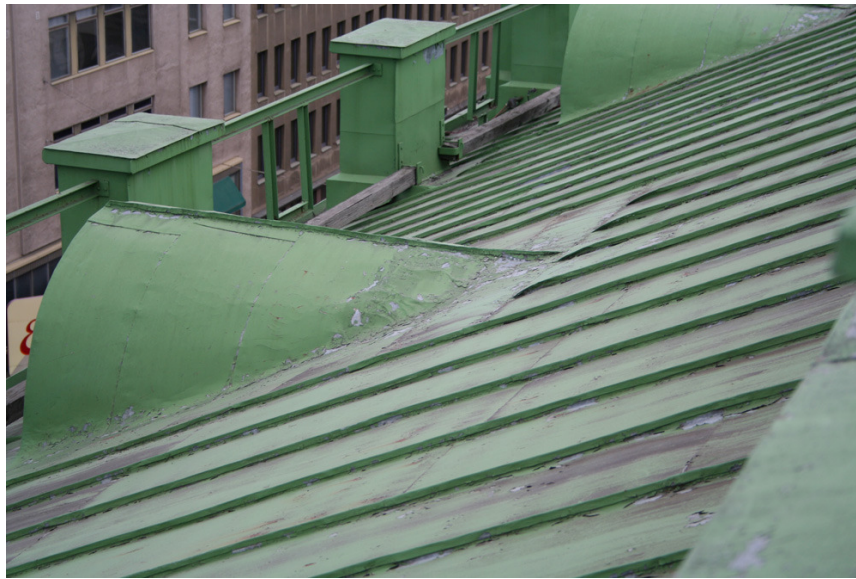
Kuva 5. Maalin hilseilyä konesaumatulla peltikatolla
