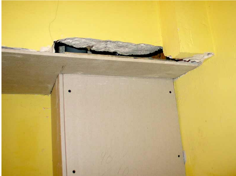
Kuva 9. Uusien vesiputkien kotelointia
