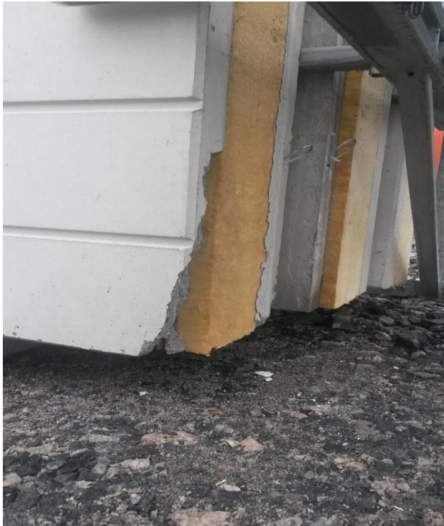
Kuva 4. Lohkeama julkisivussa (Perttu Mäntynen, 2014)
