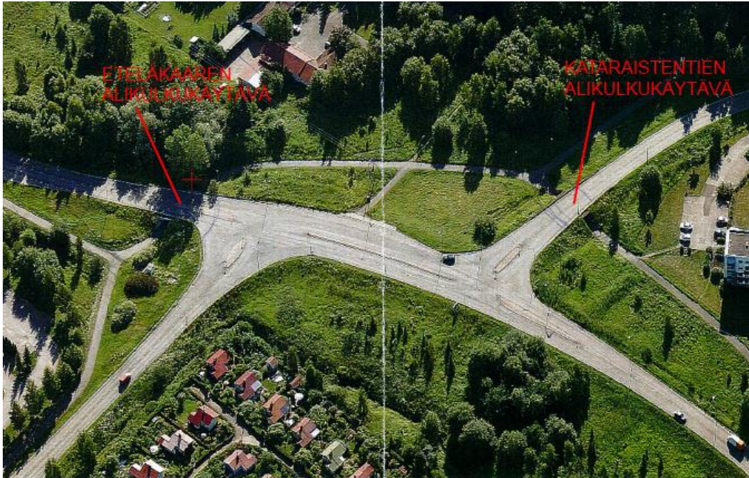
Kuva 2. Ilmakuva Eteläkaaren ja Kataraisentien siltapaikoilta.
