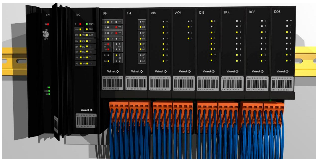
Kuva 3. ACN I/O 80-asennusalue. (11)
