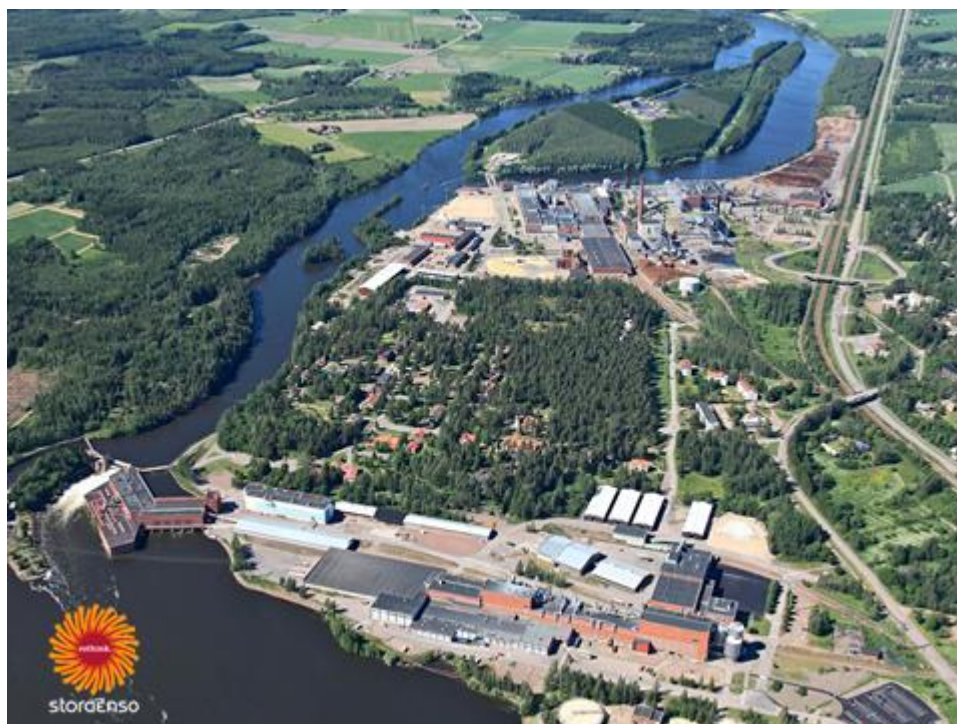
Kuva 1. Stora Enso Anjalankosken tehtaat. (1)
