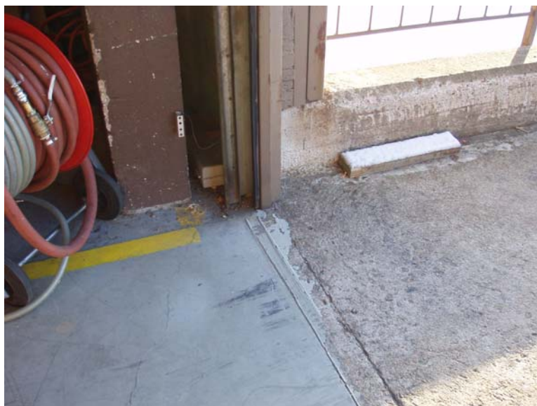
Kuva 1. sillan ja lattian liitos
