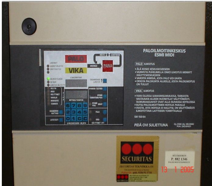
Kuva 3, Paloilmoitinkeskus ESMI MIDI uusitaan vuonna 2005
